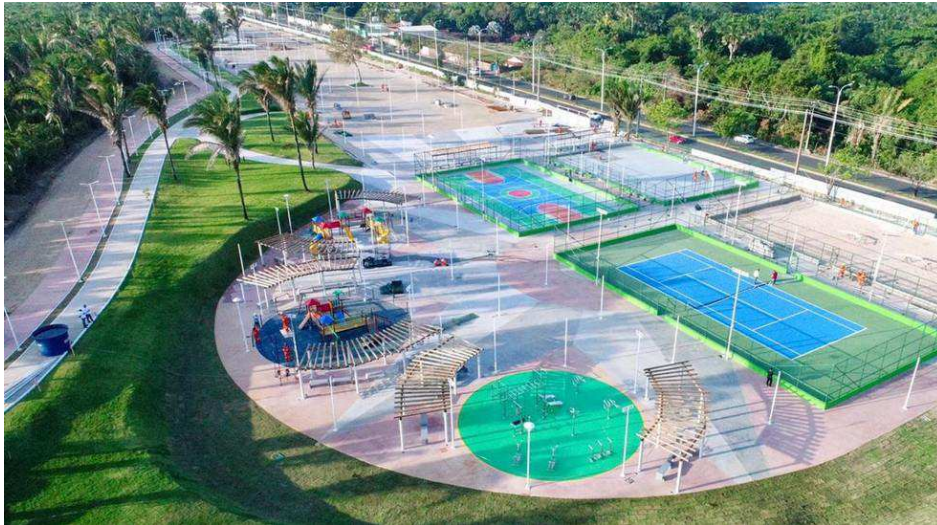
Figura 38 - Vista Aérea do Parque do Rangedor
