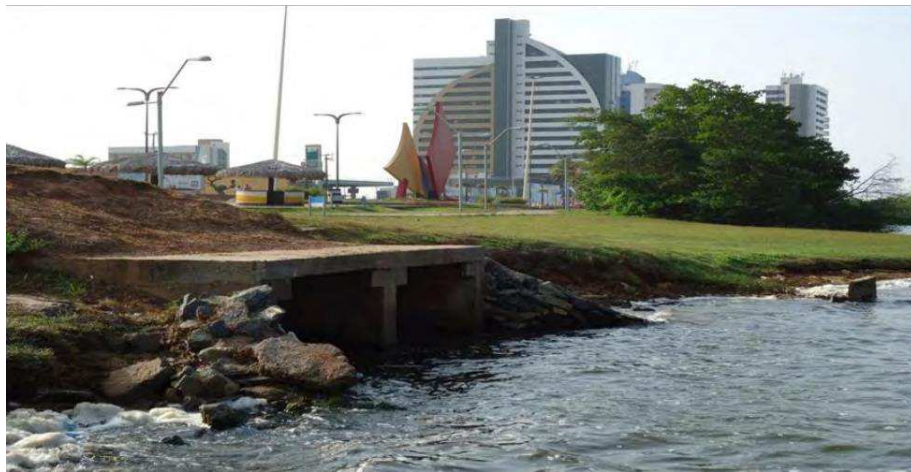
Figura 44 - Foto de Bueiro Celular instalado sobre o Igarapé da Jansen
