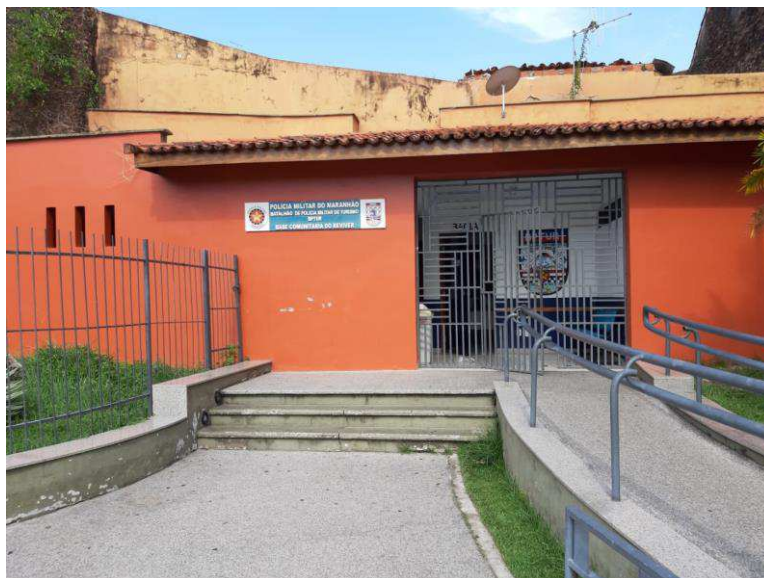
Figura 4.5: Prédio da 3 CIA do BPTur na praça Nauro machado.
