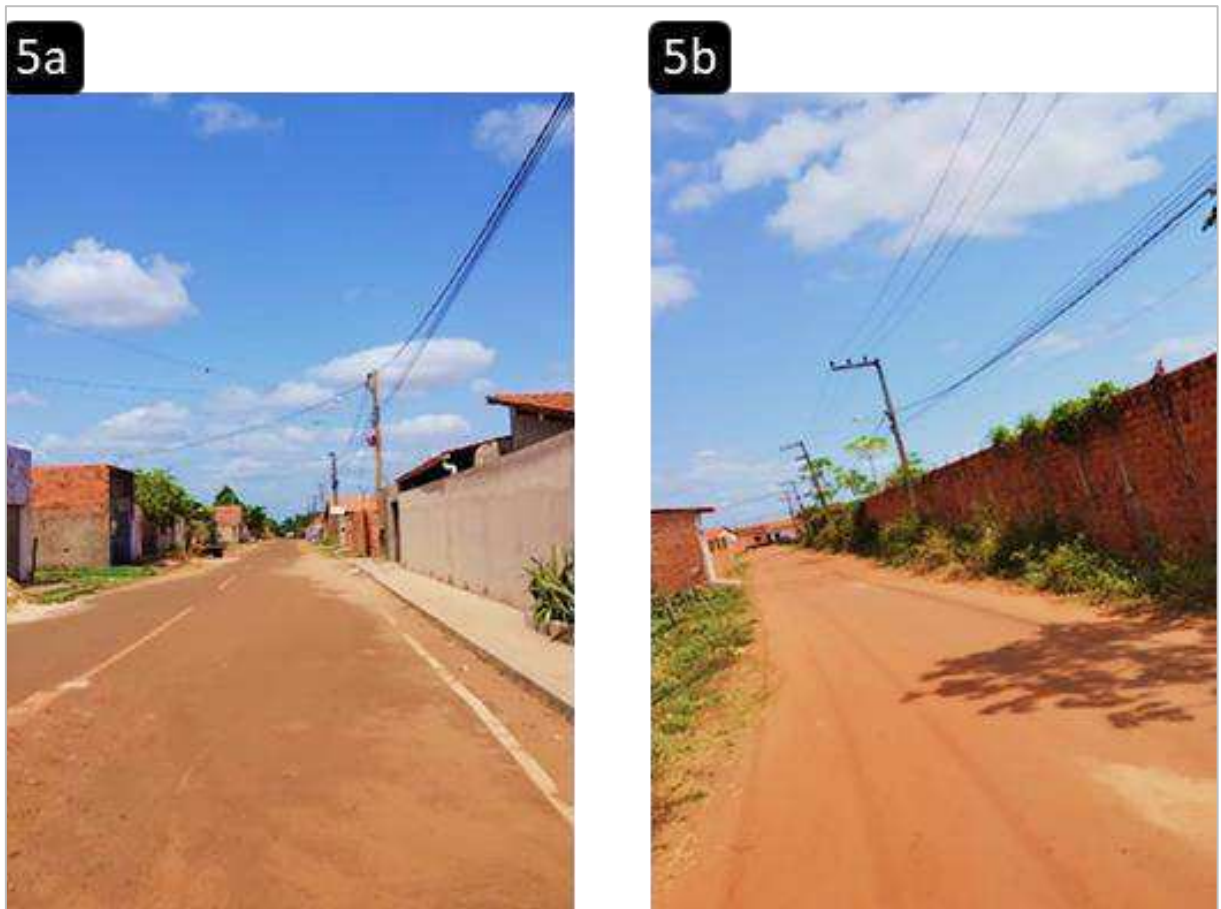
Figura 5. Ruas do bairro Vila nova III. (a) e (b) áreas de moradias com pavimentação
