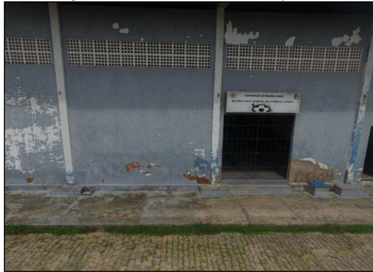
Figura 5 - Fachada do Ginásio Poliesportivo
