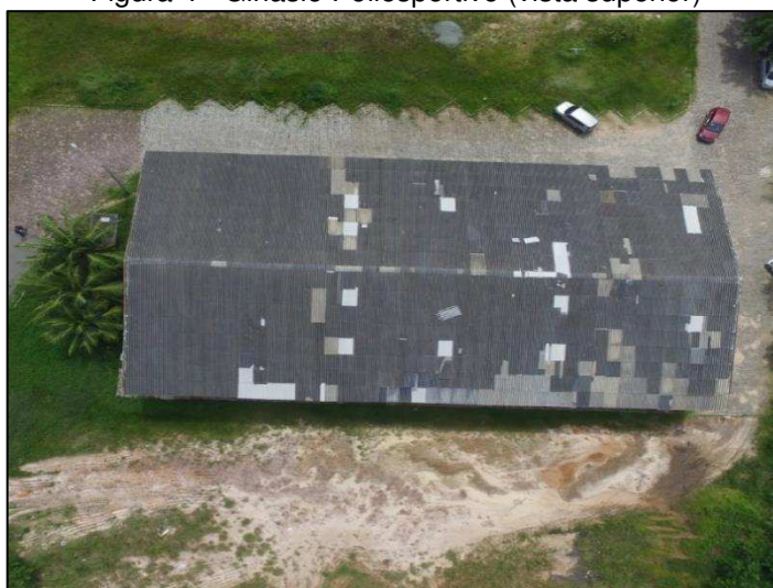
Figura 4 - Ginásio Poliesportivo (vista superior)
