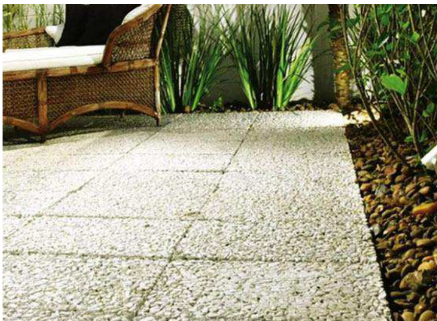
Figura 6 - Exemplo de piso permeável drenante.
