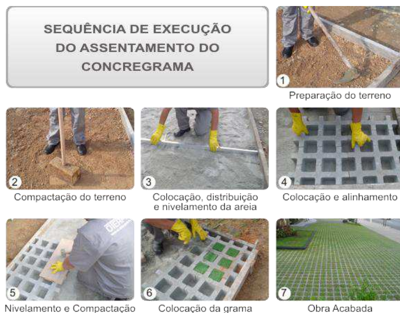
Figura 5 - Execução de concregrama.
