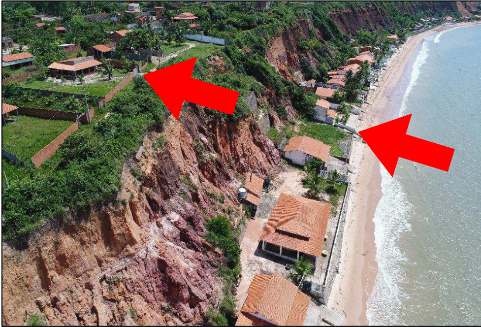
Figura 51 - Loteamento para construção de condomínio na praia de Ponta Verde, São José de Ribamar.
