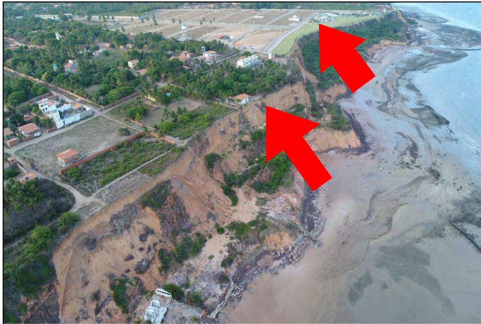
Figura 49 - Propriedades ainda utilizadas no tabuleiro e na praia de Ponta Verde, São José de Ribamar.
