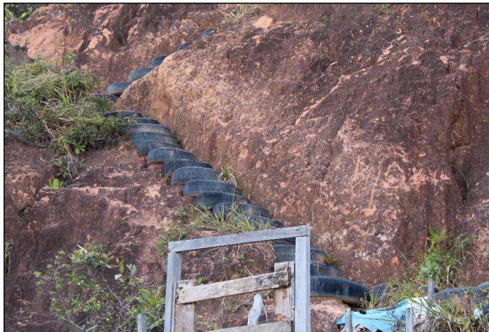
Figura 12 - “Escada de pneu”.
