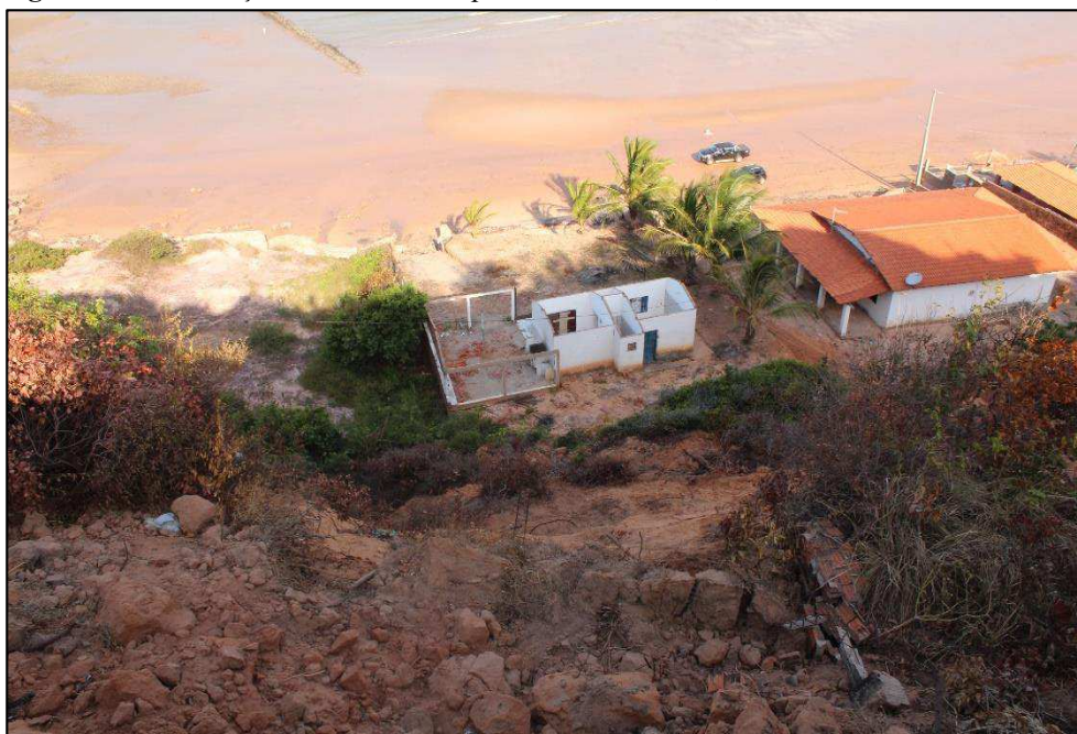
Figura 50 - Construção abandonada na praia de Ponta Verde, São José de Ribamar.
