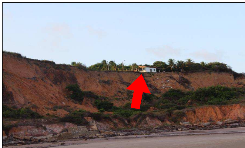
Figura 57 - Casa com estrutura comprometida na porção superior da falésia em Ponta Verde, São José de Ribamar.
