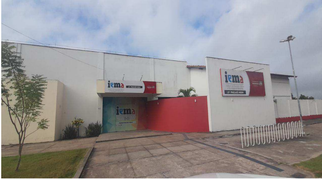
Figura 4- Fachada do IEMA-Up Pindaré Mirim
