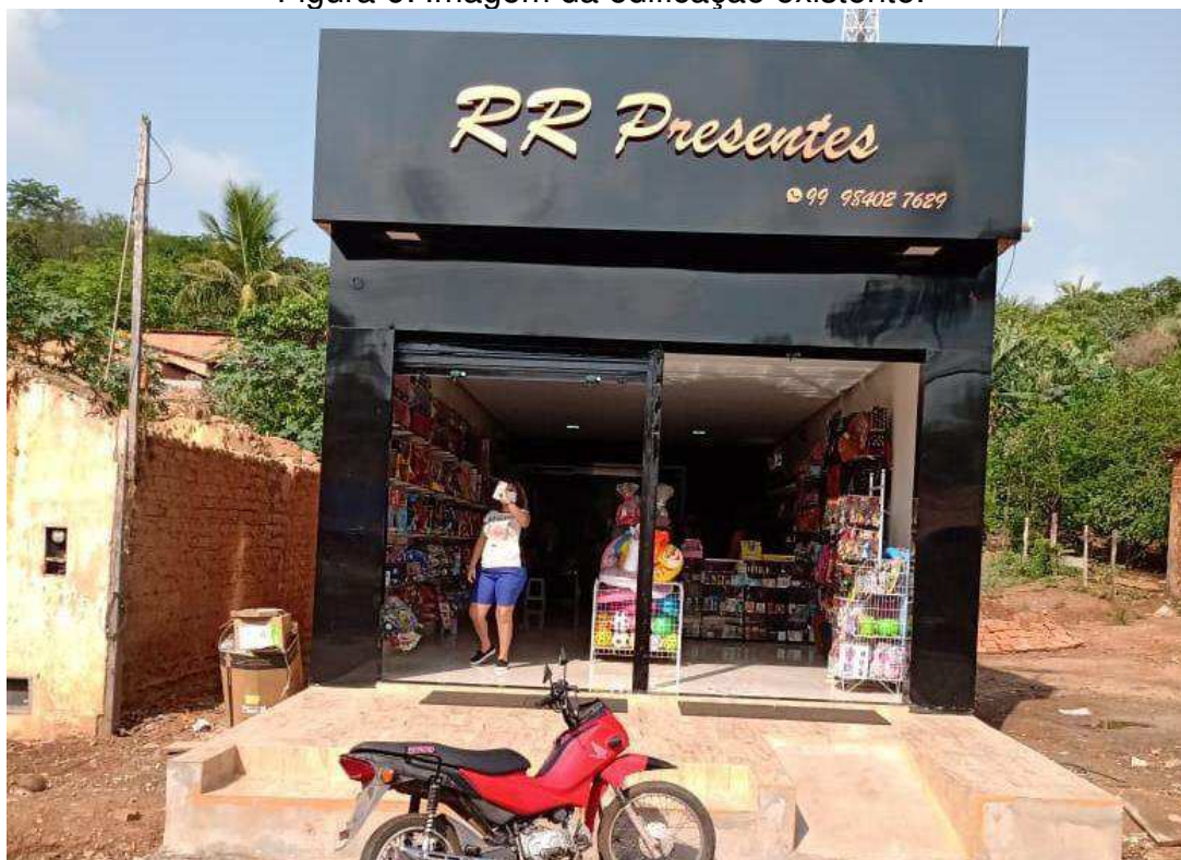
Figura 6: Imagem da edificação existente.
