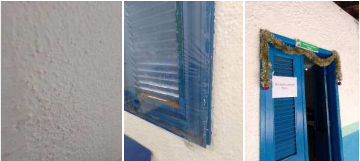
Figura 11. Paredes e esquadrias da escola de música
