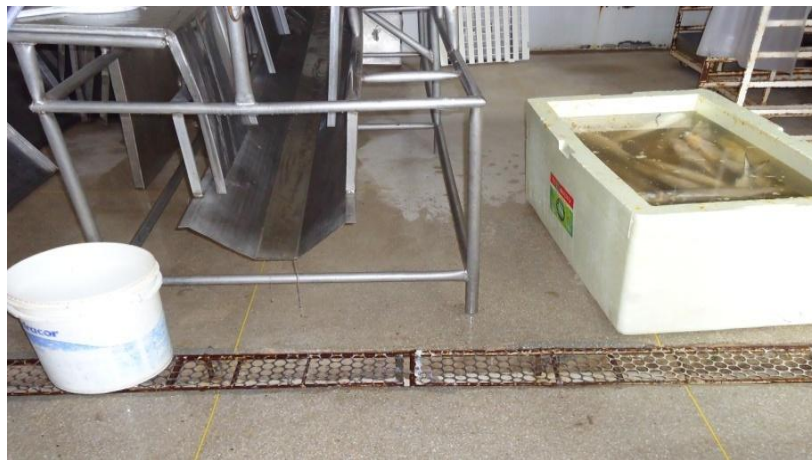
Figura 10 - Entrepasto de pescado A - Móveis: presença de móveis oxidados.
