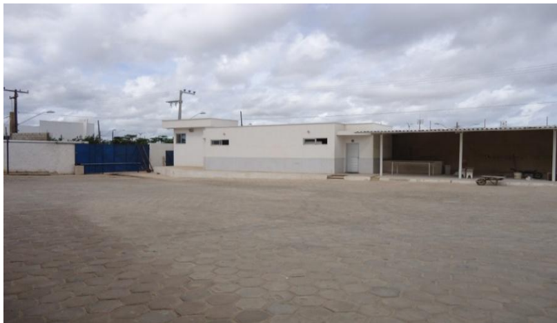
Figura 03- Entrepasto de pescado A - Instalações sanitárias e vestiários para manipuladores: acesso à área de produção sem cobertura.
