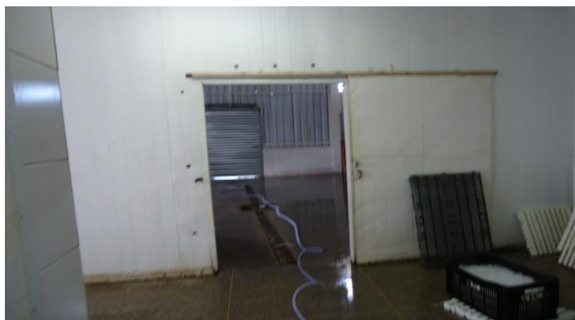
Figura 04- Entrepasto de pescado A - Fluxo de produção: área de pré-preparo sem isolamento da área de preparo. Edificação: portas desajustadas aos batentes.
