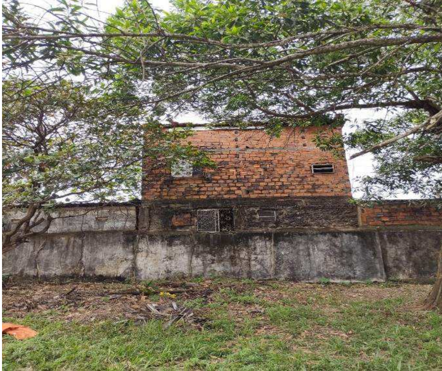
Figura 9 - Janela vizinha na direção do quartel
