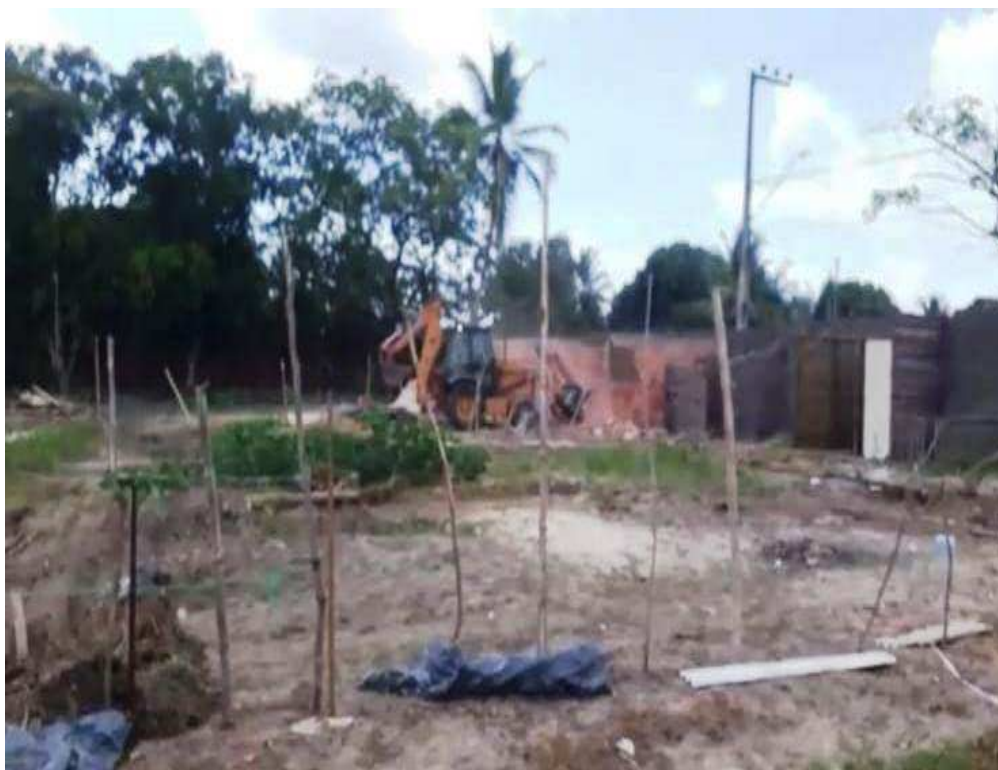
Figuras 20 (A e B) – Derrubada de barracos e desocupação de terreno no bairro da Mata
