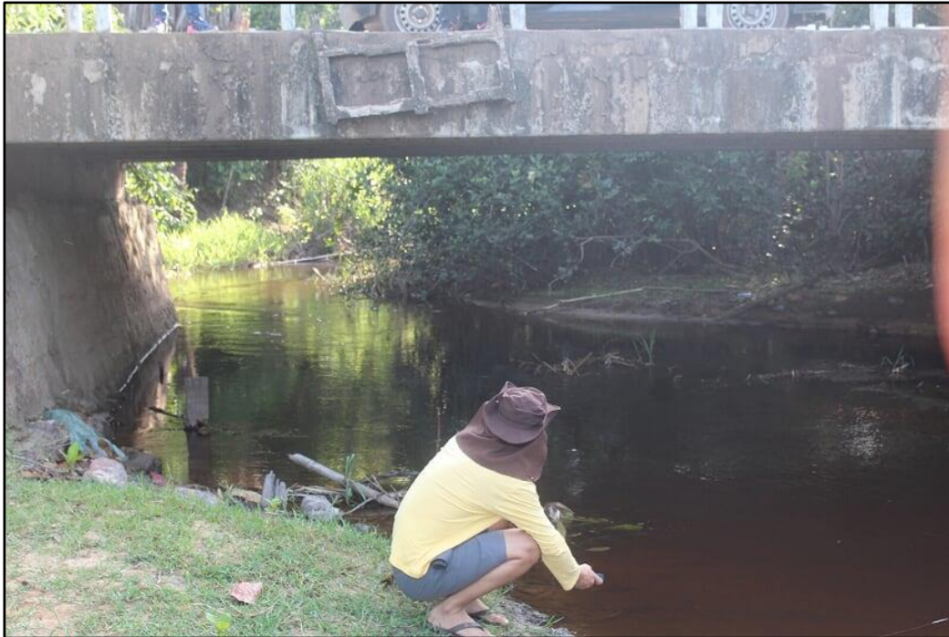
Figura 34- Ponte sobre o Boa Hora, bairro da Queimada
