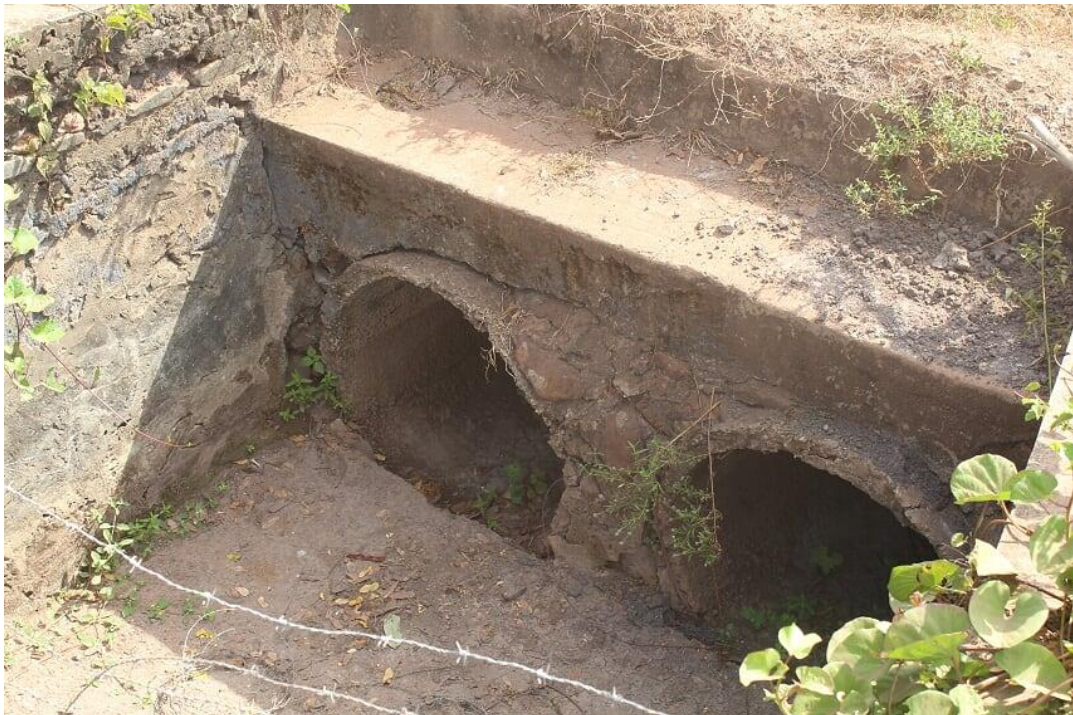
Figura 41 - Bueiro de açude com saída para o riacho da Boa Hora
