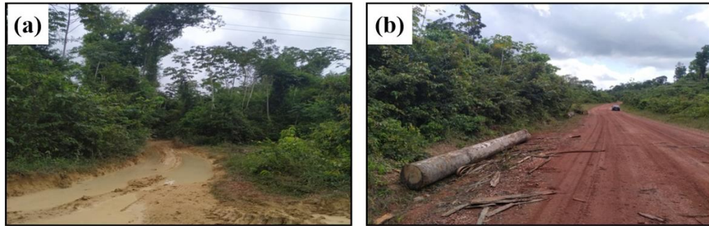
Figura 10 – (A) Ramal às margens da Estrada da Maritaca, em Paragominas-PA; (b) Toras às margens da Estrada da Maritaca
