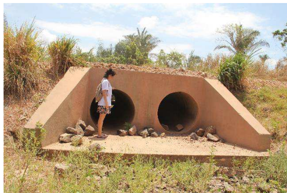
Imagem 7 - Calhas para passagem do igarapé do Mel sob a estrada de acesso comparada ao vão para sua passagem sob a EFC.
