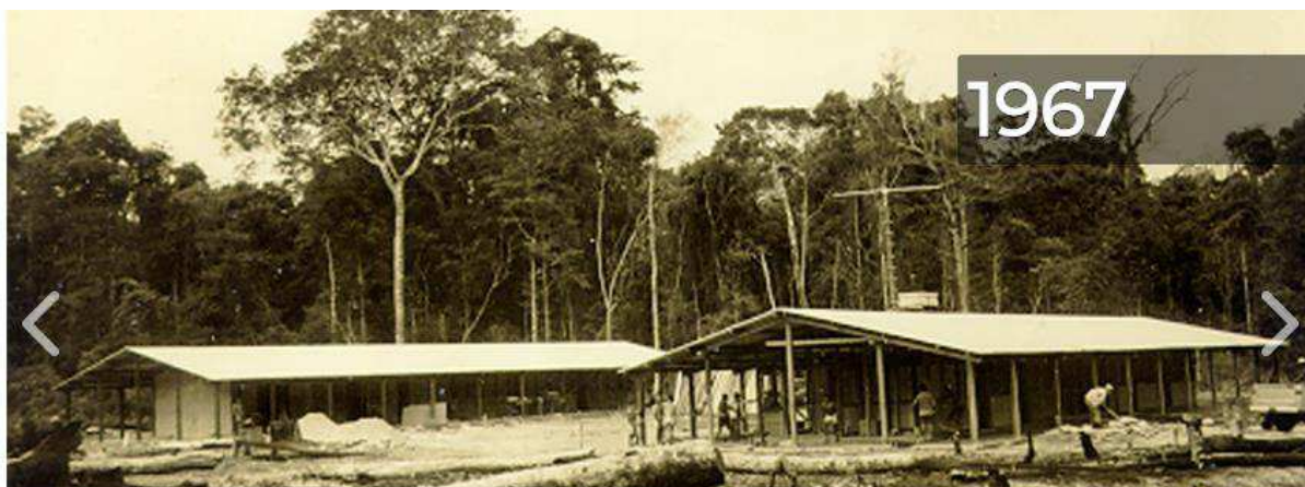
Figura 8: Primeiras estruturas das empresas mineradoras no Trombetas
