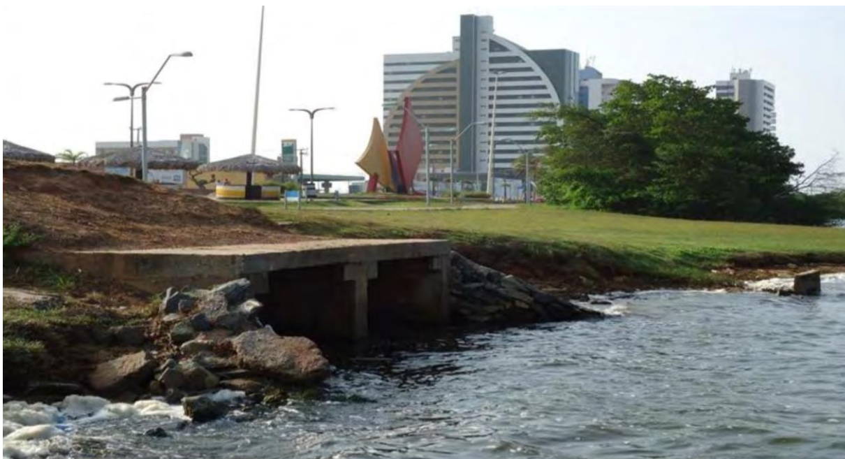
Figura 11– Bueiro duplo celular. Única ligação da lagoa da Jansen ao mar, não sendo suficiente (2011)
