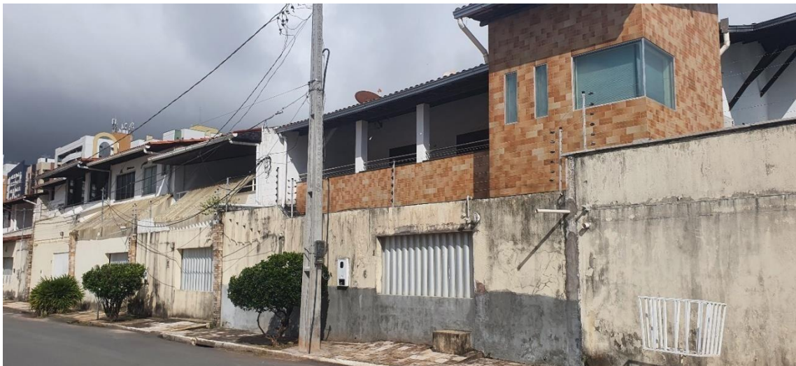
Figura 41 – Meia parede construída na frente do portão para evitar que a água da chuva adentre as residências da Lagoa da Jansen.
