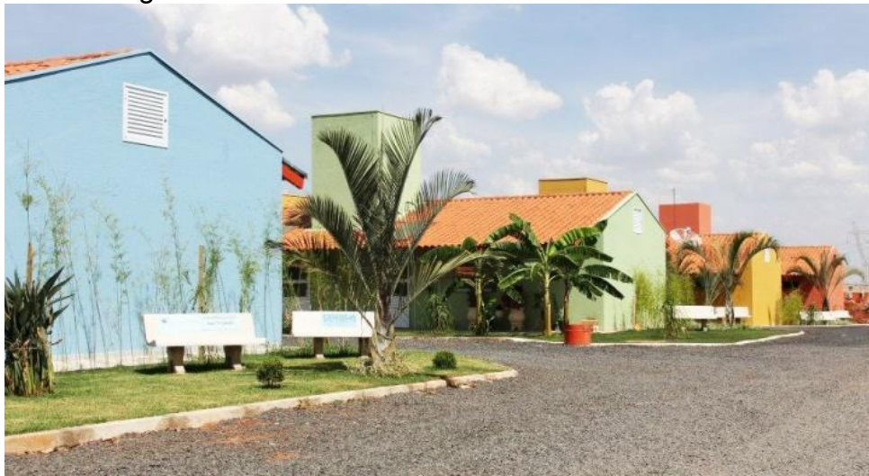
Figura 5 - Suítes-flats do Condomínio AGERIP
