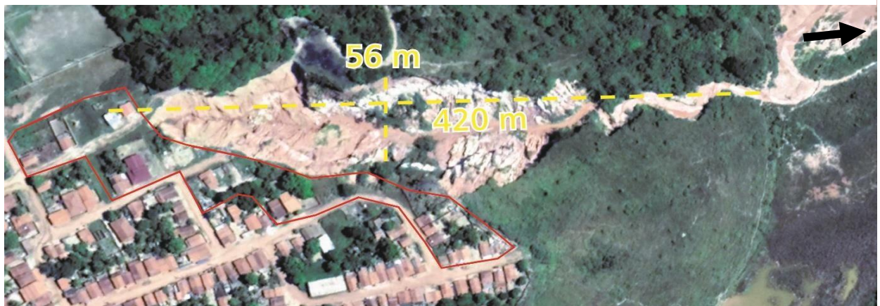
Figura 21 - Dimensões da voçoroca do bairro Santos Dumont e indicação da área de risco
