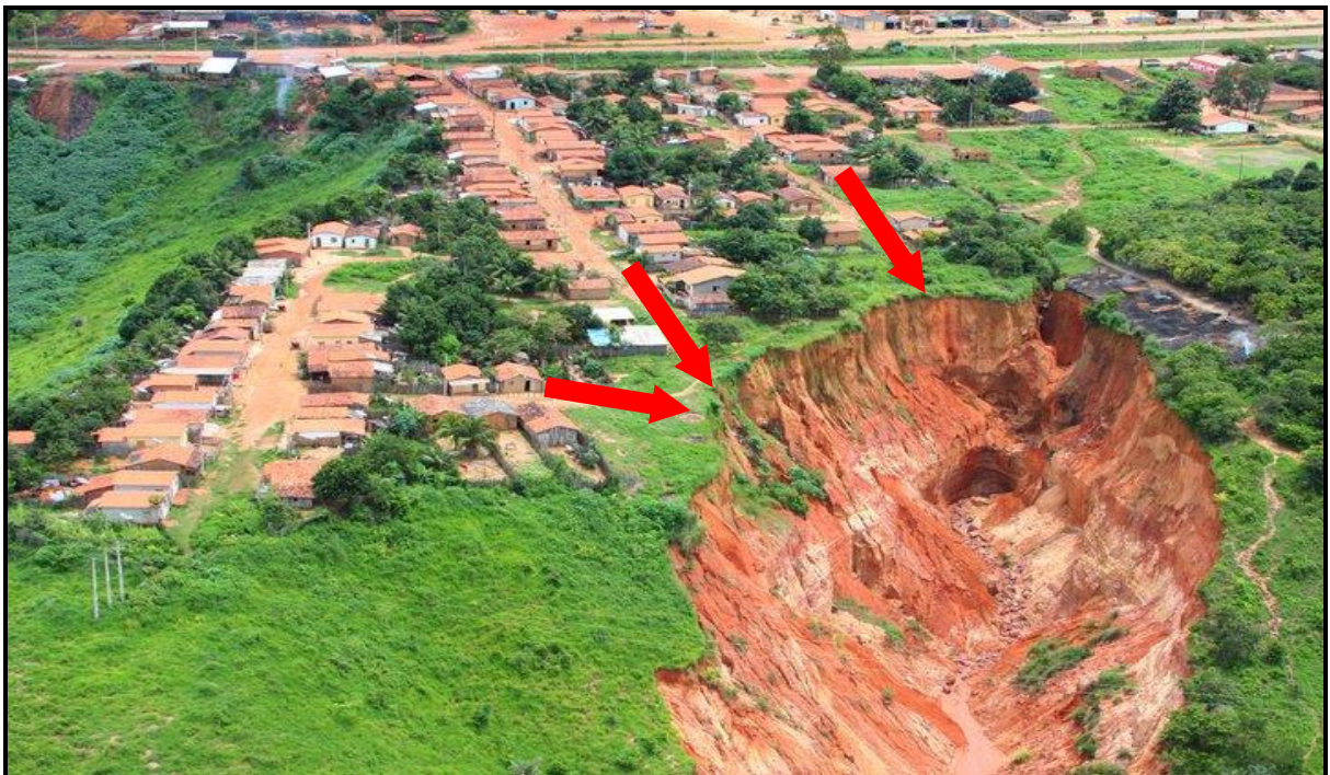
Figura 25 - Vista aérea da voçoroca com indicação do sentido de escoamento superficial das águas pluviais e servidas para as bordas ativas da feição erosiva
