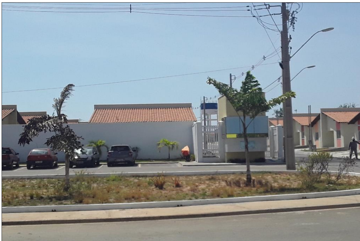
Figura 19 - Condomínio fechado em obras no polo agrícola do Iguaiába.
