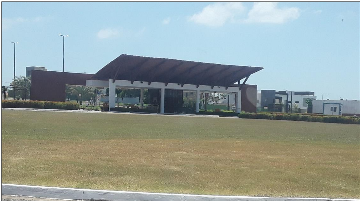
Figura 6 - loteamento fechado Alphaville Araçagy.
