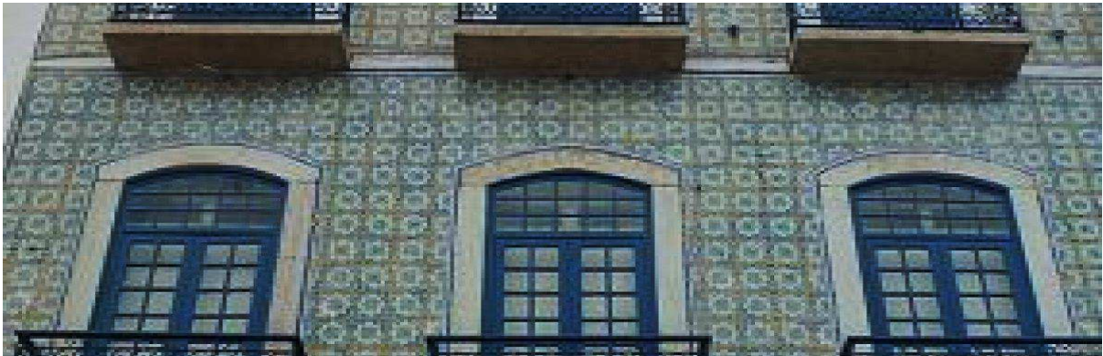
Figura 2: Fachadas de azulejos da cidade de São Luís – MA. Fonte://www.google.com.br/imigres.
