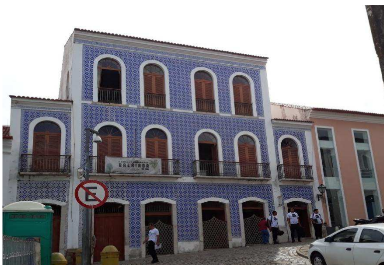
Fotografia 18 – Prédio Rua da Estrela. Depois da reforma. Curso de História UEMA. Fonte: Registro fotográfico do autor (2018)
