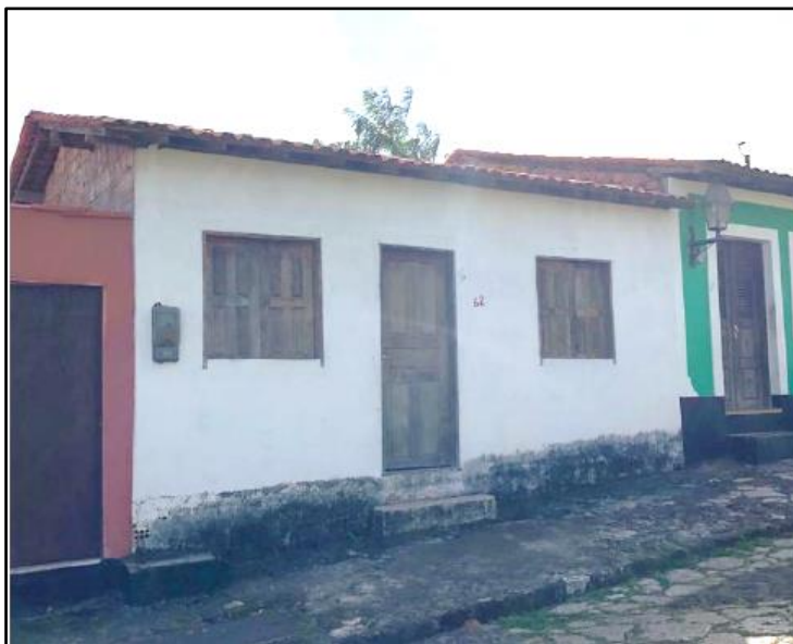
Figura 22 - "Casa de Projeto" construída em Alcântara - MA.
