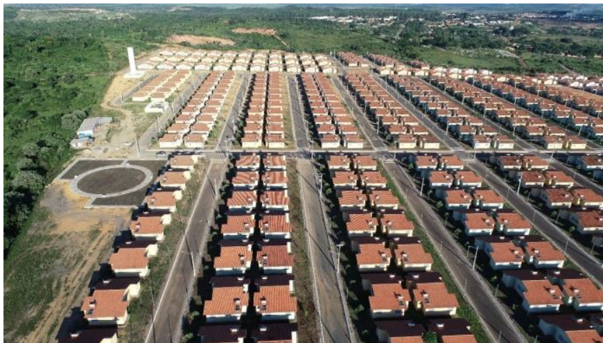
Figura 14- Residencial Aulídia Gonçalves produzido pelo MCMV em Açailândia - MA.
