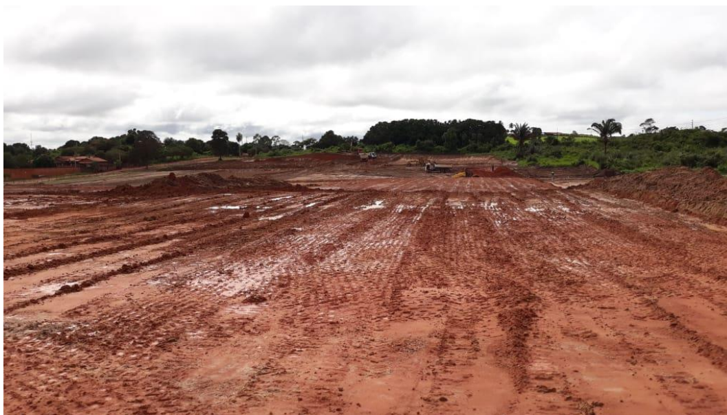
Figura 19 - Terraplenagem do terreno para o Reassentamento de Piquiá de Baixo.
