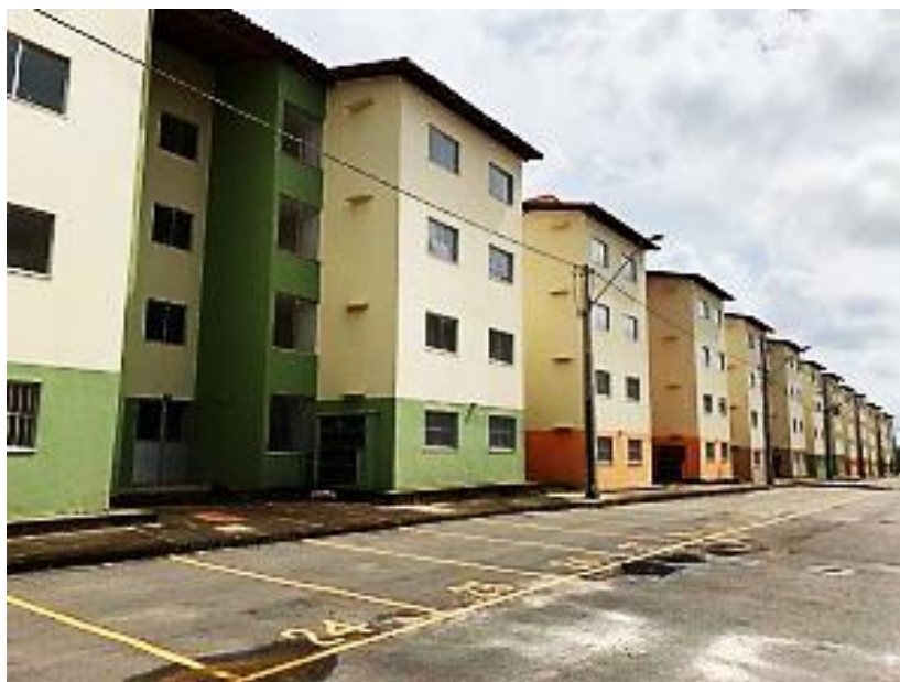
Figura 2 - Conjunto Habitacional construído pelo MCMV no Maranhão.
