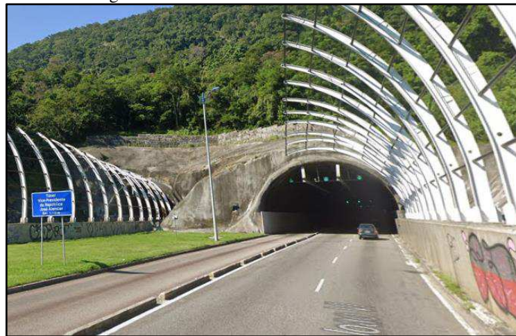
Figura 14 - Visão Frontal da abertura do túnel
