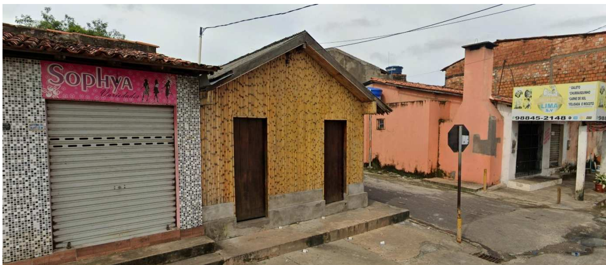
Figura 75 - Registro da fachada do Bambu Bar.
