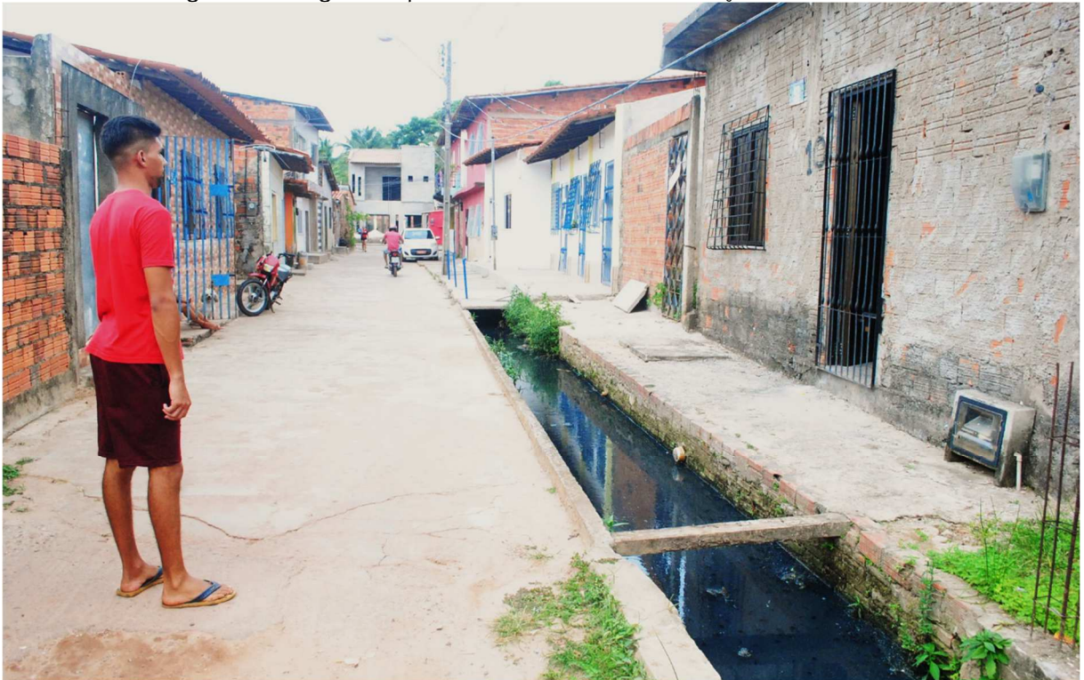
Figura 71 - Esgoto exposto em acesso de habitação no Sá Viana.
