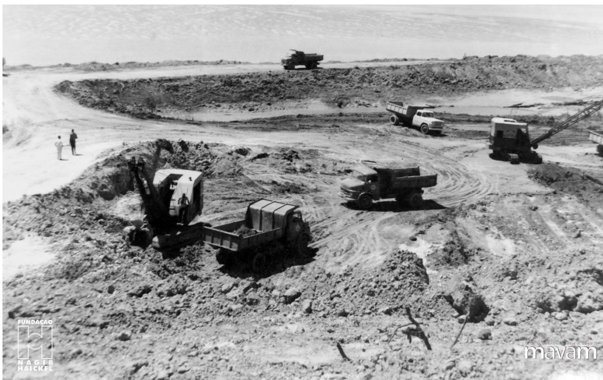
Figura 43 - Obras de construção da Barragem do Bacanga, 1969.
