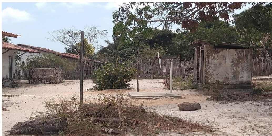
Figura 7: À esquerda, o banheiro rústico construído pelos moradores e à direita, pelo CLA
