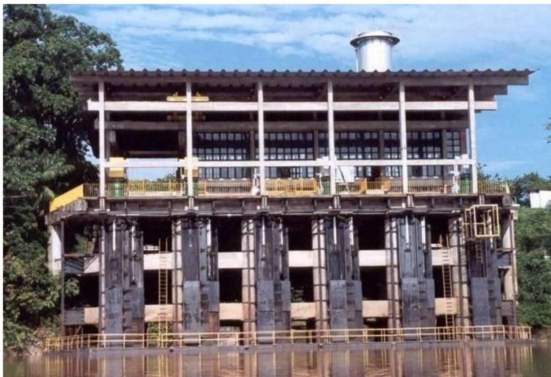
Figura 1 - Elevatória de água bruta do Italuís, em Bacabeira-MA
