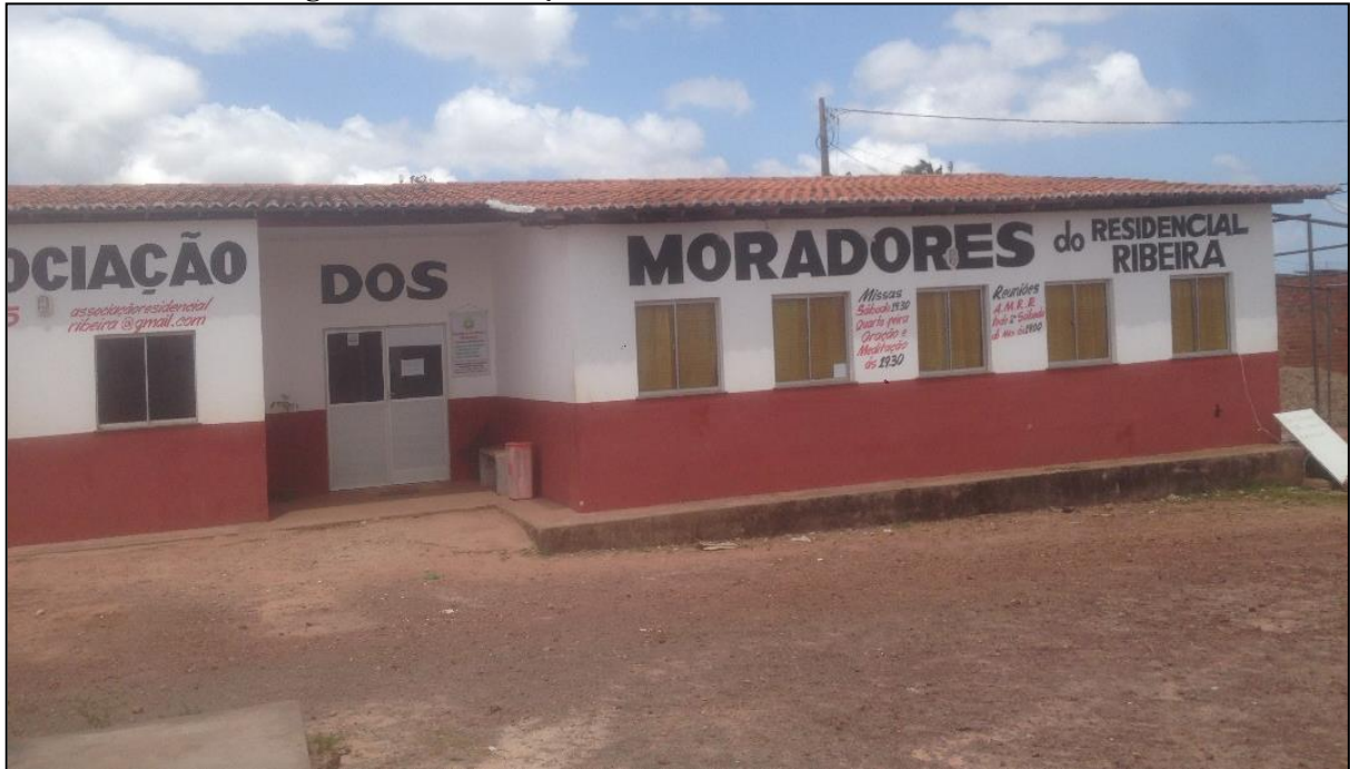
Figura 37 - Associação de moradores do Residencial Ribeira.
