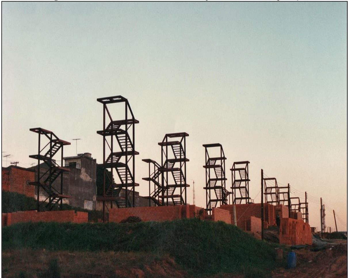
Figura 24 - Escadas em estrutura metálica Conjunto Juta – Nova Esperança.
