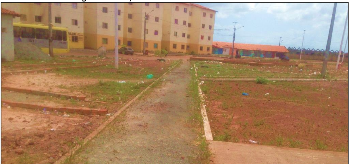
Figura 39 - Calçada na área central do Residencial Ribeira.
