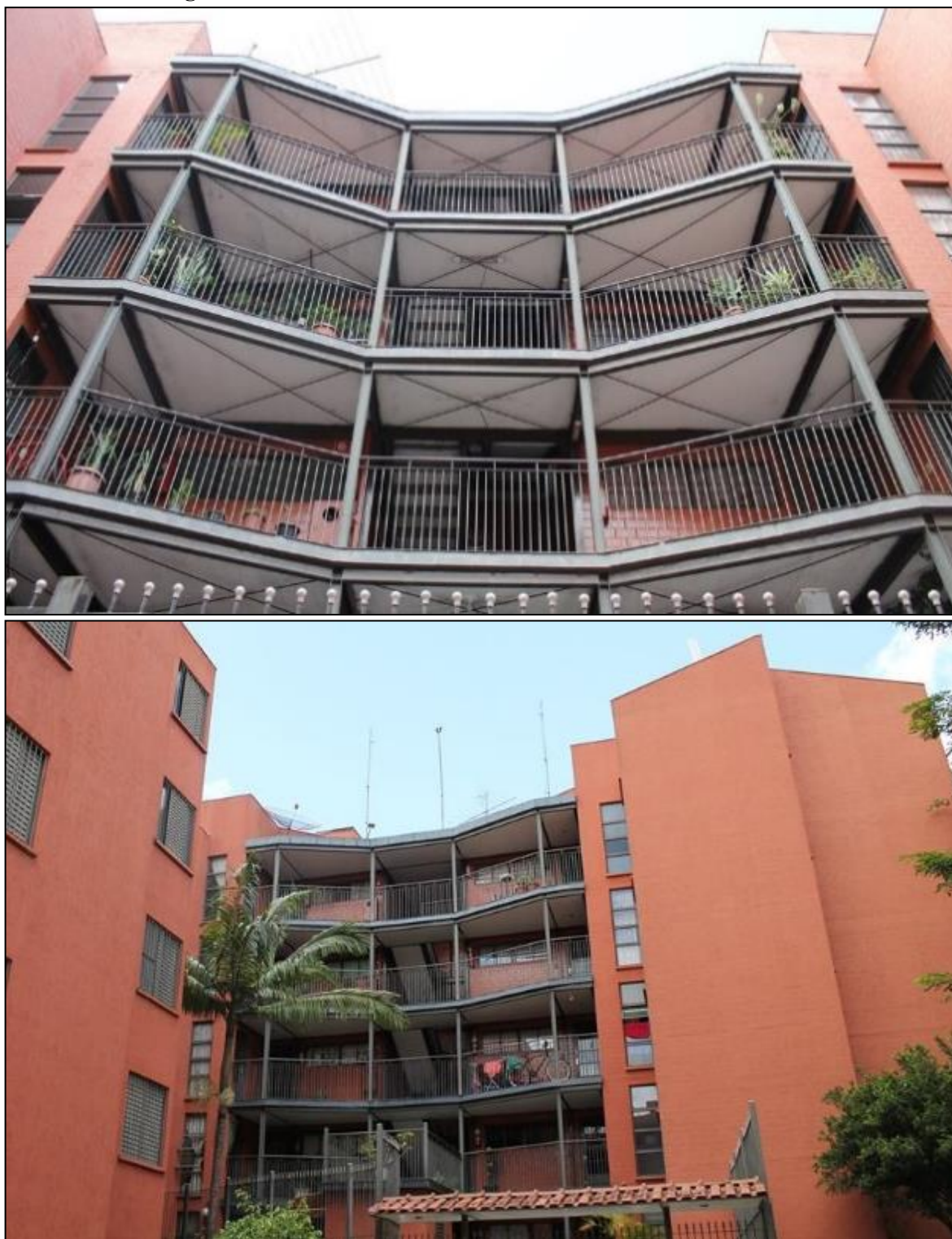
Figura 15 - Fachadas de edifícios - COPROMO em Osasco-SP.
