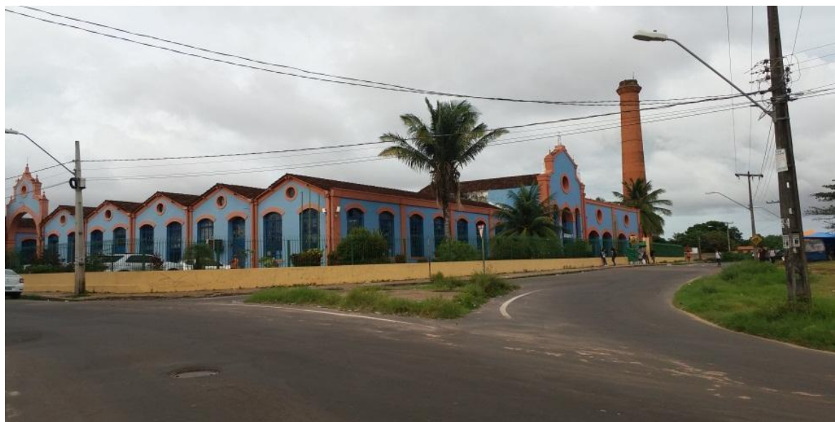
Figura 9 – Forma da antiga Fábrica de Tecidos Rio Anil, atualmente Escola CINTRA
