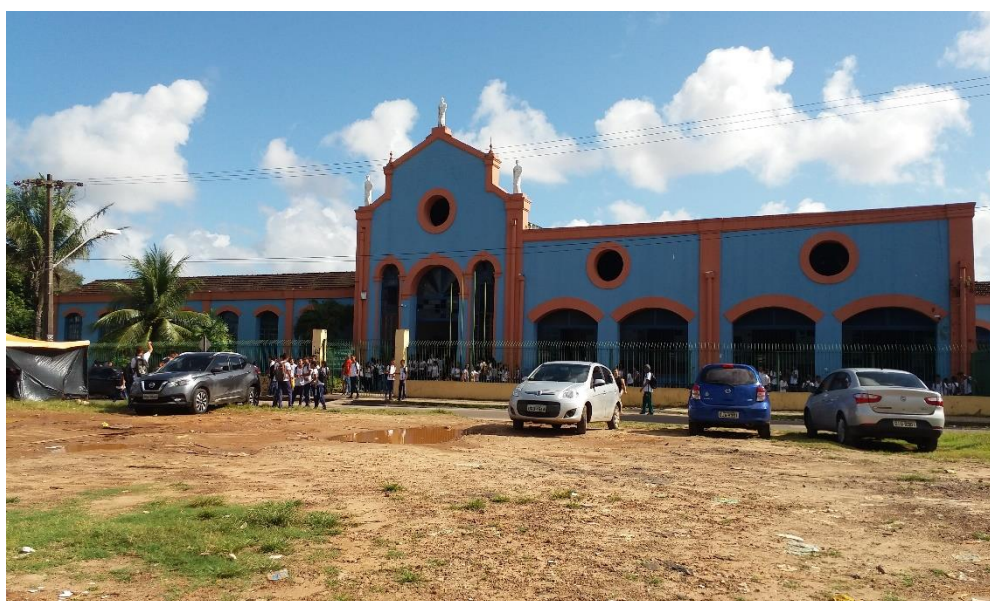
Figura 24 – Uma das entradas de acesso ao Centro Integrado do Rio Anil – CINTRA
