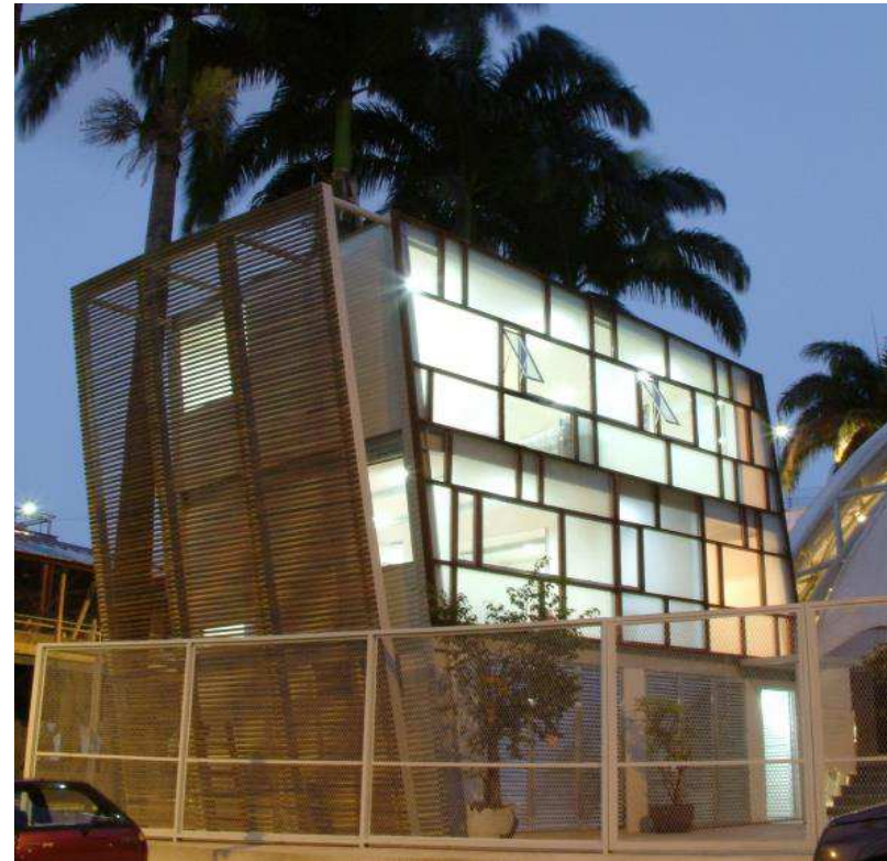
Figura 33. Fachada externa dos prédios administrativo e camarins
