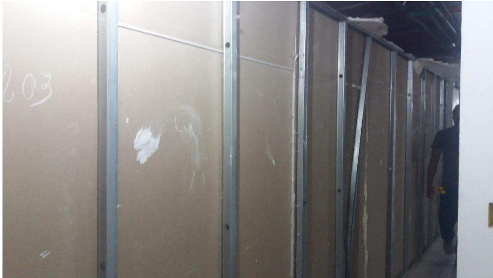
FIGURA 15: Montagem da estrutura metálica da alvenaria
