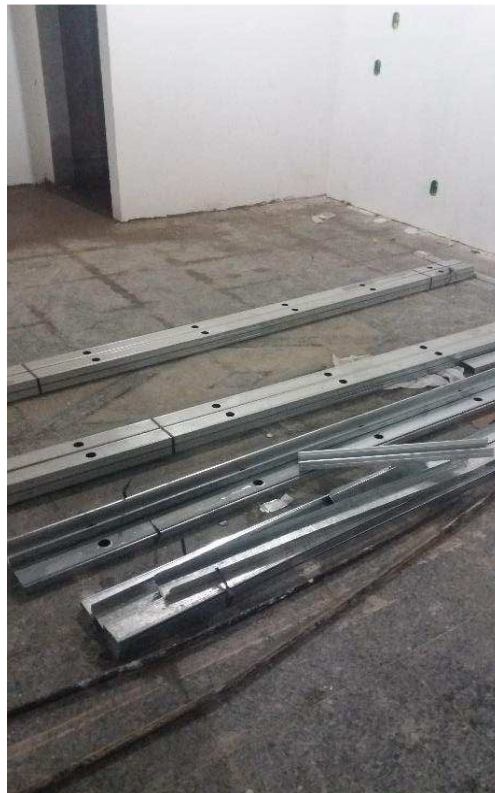
FIGURA 14: Guias e montantes de metal para a armação da alvenaria.
