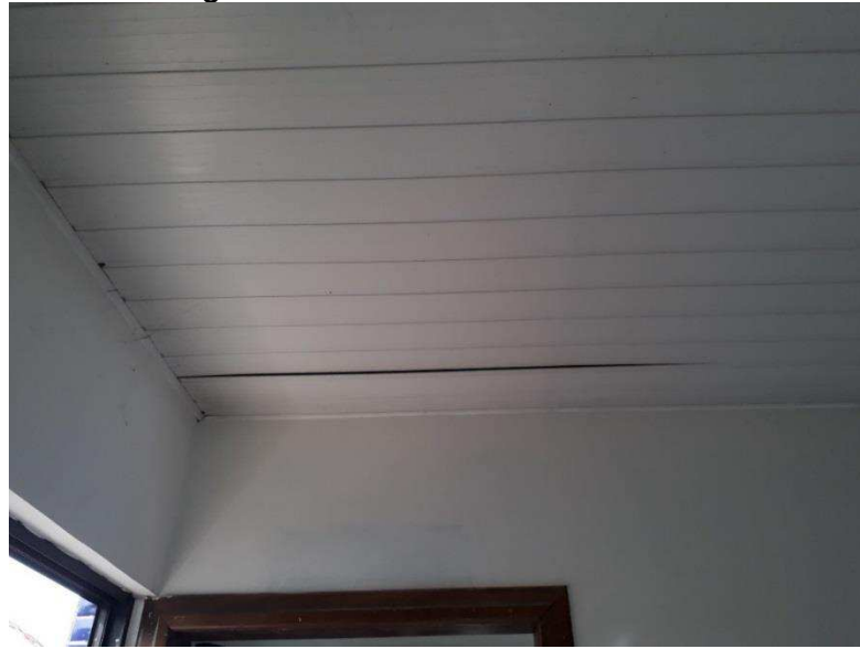
Figura 17 - Assentamento de forro PVC
