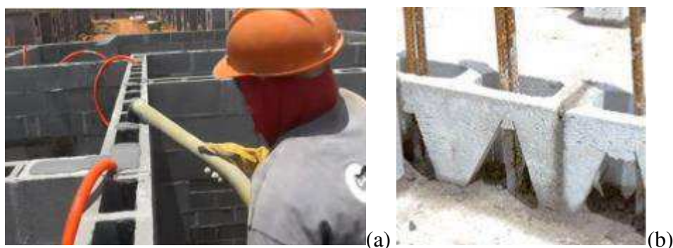
Figura 19: (a) lançamento do graute e (b) furos de visita.
