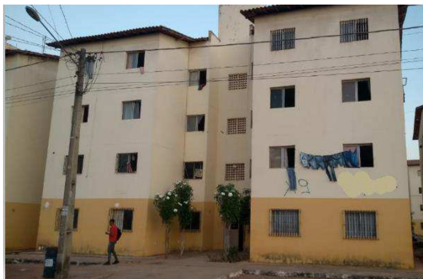
Figura 79: Fachada estudo de caso II.
