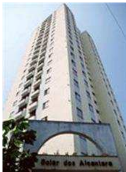
Figura 14: Edifício Solar dos Alcântaras, em São Paulo/SP.
