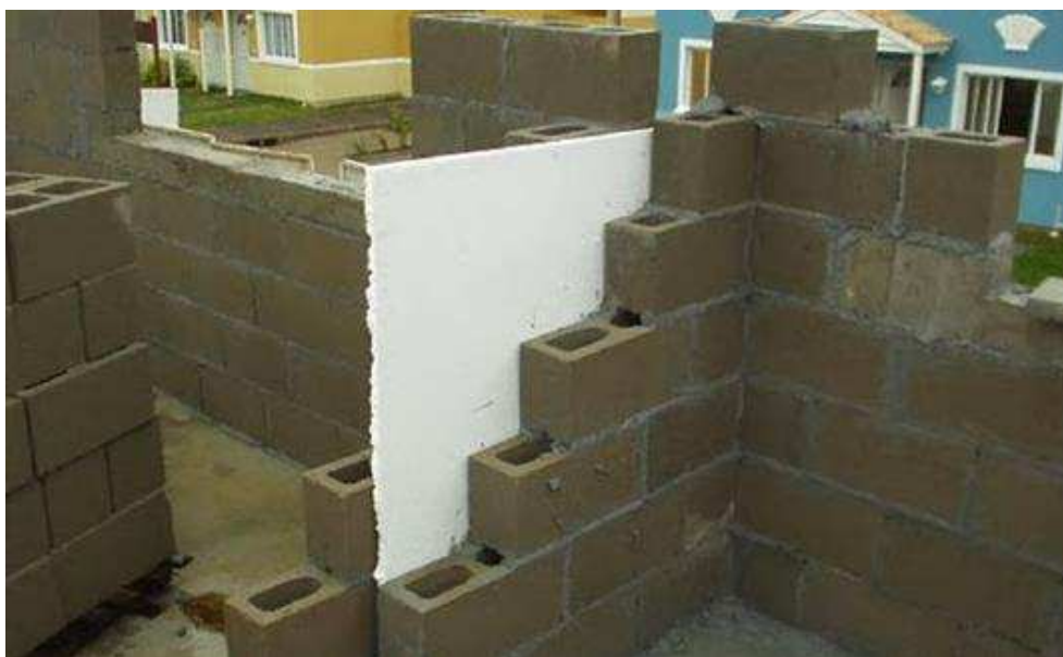
Figura 33: Junta de dilatação em execução.
