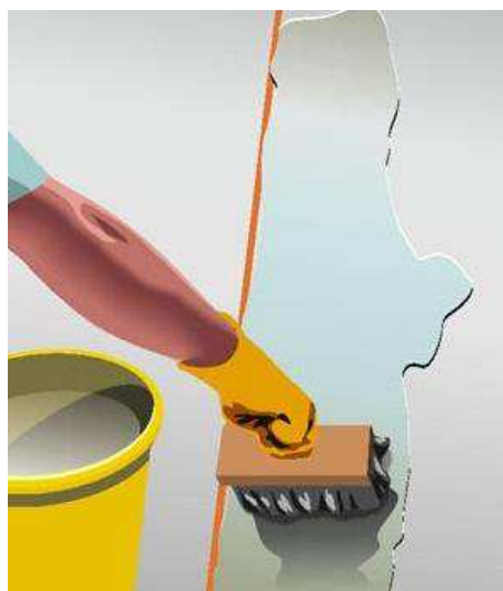
Figura 48: Umedecimento da superfície do pavimento para posterior assentamento de primeira fiada.
