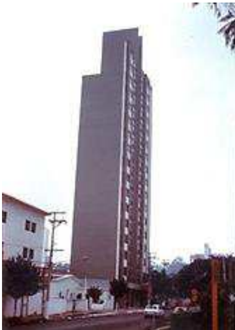
Figura 11: Edifício Muriti, São José dos Campos/SP.
