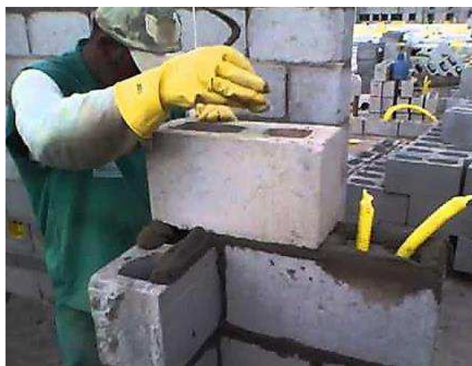
Figura 30: Instalação elétrica embutida verticalmente nos furos do bloco ainda em assentamento.
