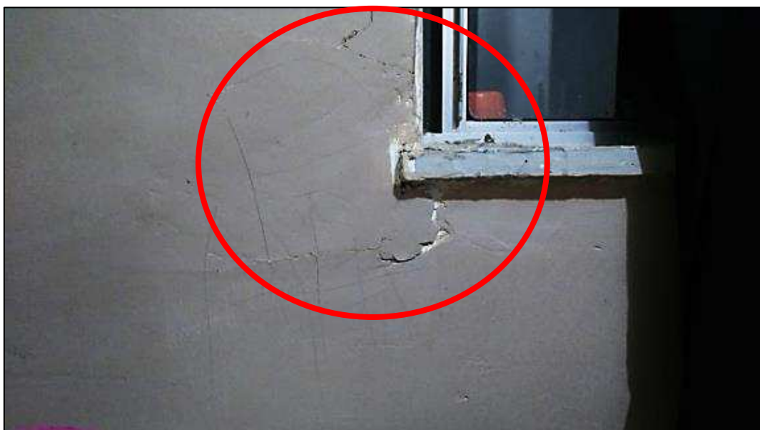
Figura 76: Fissuras inclinadas no canto inferior de esquadria do quarto 01.
