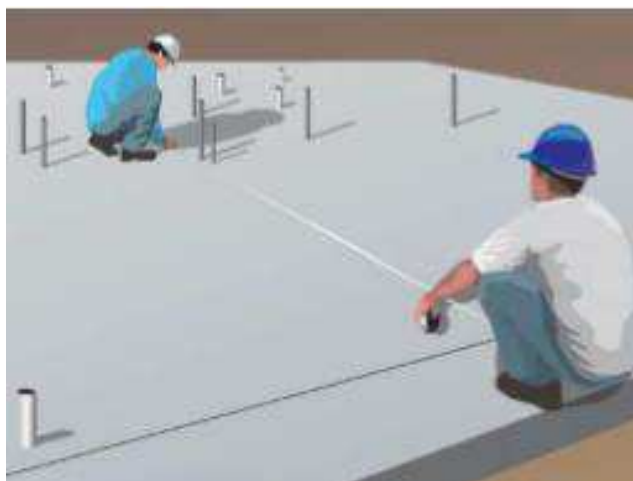
Figura 46: Marcação das direções e alinhamento das paredes com o fio traçante.
