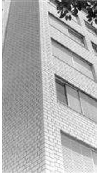
Figura 13: Edifício Jardim Prudência, em São Paulo/SP.
