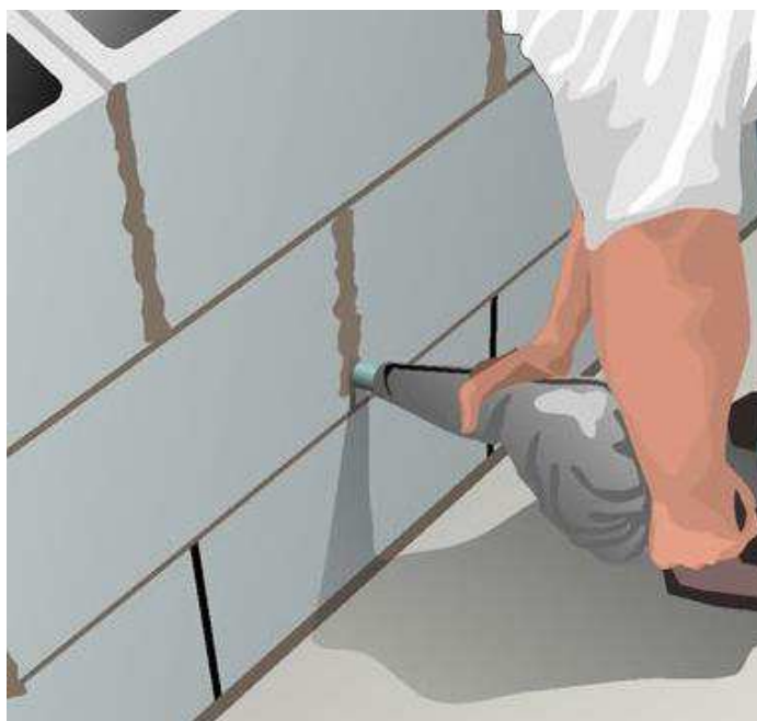
Figura 36: Bisnaga para assentamento de argamassa.
