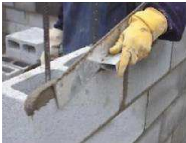
Figura 35: Palheta utilizada no assentamento de argamassa.
