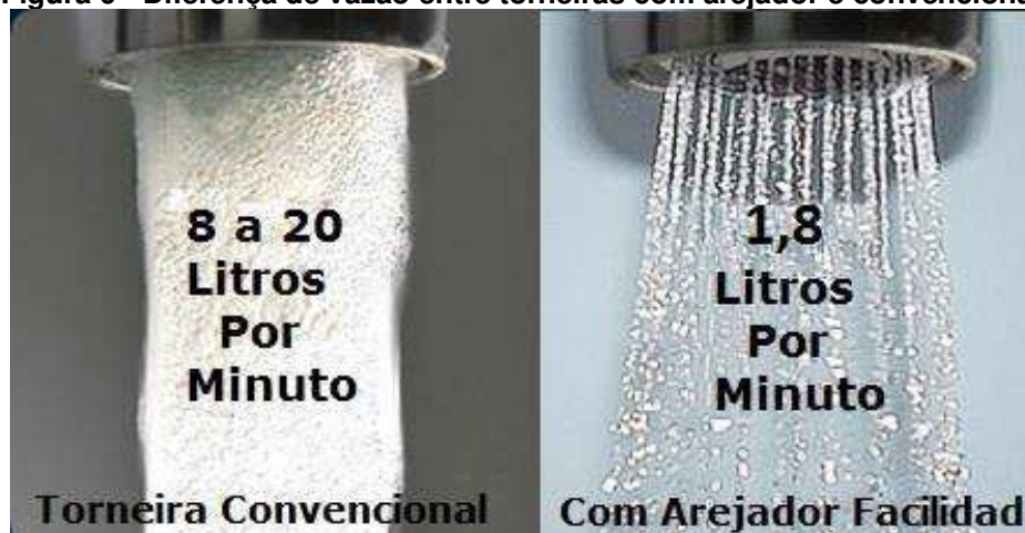
Figura 9 - Diferença de vazão entre torneiras com arejador e convencional.
