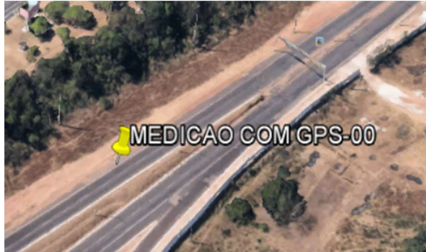
Figura 28 – LOCAÇÃO DE MEDIÇÃO -GPS 00
