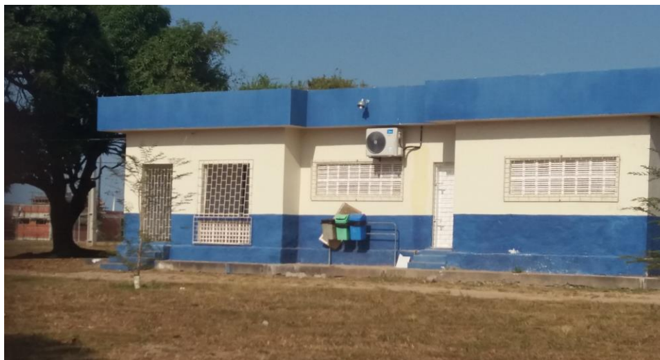
Figura 11 - Foto de lixeiras seletivas quebradas no prédio do curso de Ciências Biológicas
