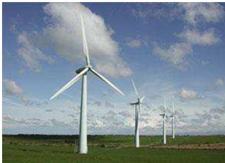
Figura 2.2 – Turbinas eólicas modernas (Adaptado de VIRGINIA CENTER FOR WIND ENERGY, 2018).
