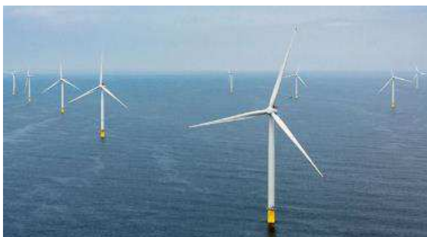
Figura 2.3 – Turbinas eólicas offshore SWT-6.0-154 (Adaptado de SIEMENS GAMESA RENEWABLE ENERGY S.A, 2014).
