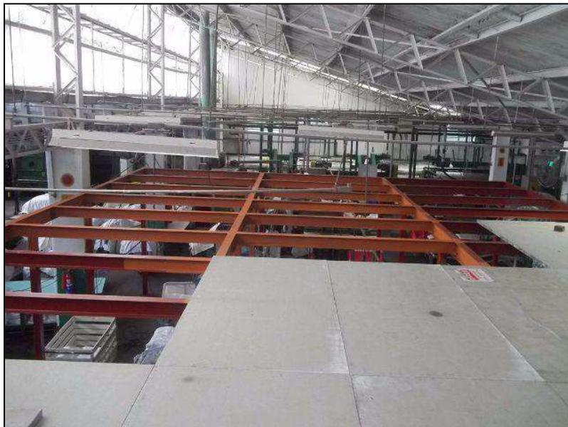
**Figura 3.11: Placa Wall durante a montagem. (LOJA7CONSTRUÇÃO, 2018)**
