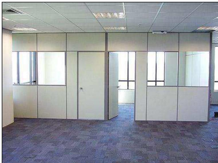
**Figura 3.8: Divisórias Duratex com portas e viseiras de vidro embutidas. (EVISOS, 2018)**
