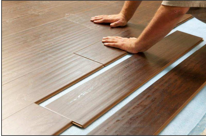
**Figura 3.12: Piso laminado durante a montagem. (MEUPRECON, 2016)**
