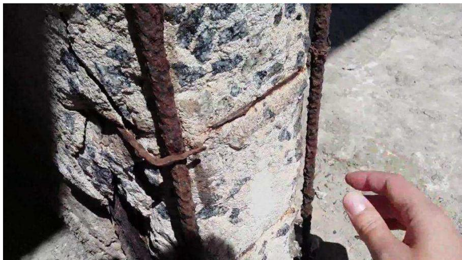
Figura 5.5 – Corrosão nas armaduras de concreto (TECNOSIL, 2018)
