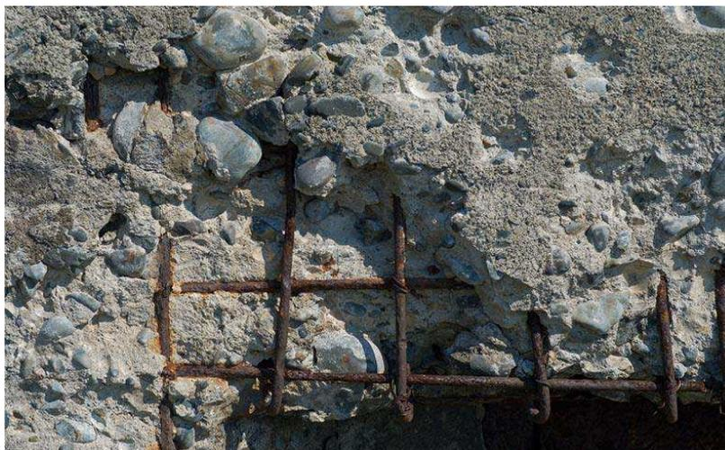
Figura 5.3 - Deterioração do Concreto Armado (VLADIMIROVICH, 2017)
