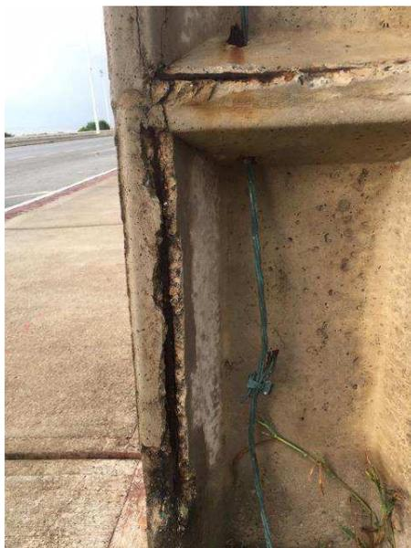
Figura 5.4 - Danos à estrutura do concreto armado em postes da região litorânea de São Luís – MA (Autor, 2019)
