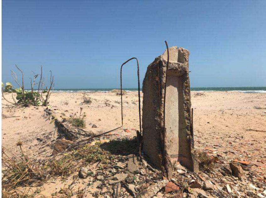
Figura 4.14 - Poste fraturado pela ação da maresia (RAIYLSO, 2017)
