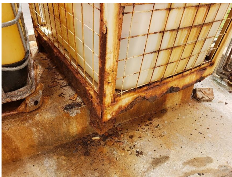
Figura 4.1 - Container de químico corroído da área (O autor, 2019)
