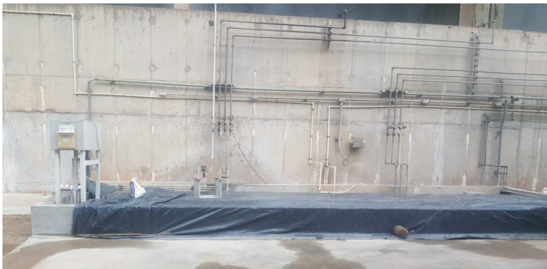
Figura 5.2 - Andamento da reforma da base de concreto (O autor, 2019)
