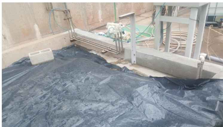
Figura 5.3 - Base de concreto coberta por lona após aplicação de cimento (O autor, 2019)
