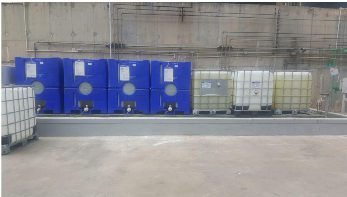
Figura 5.4 - Base de concreto reformada (O autor, 2019)
