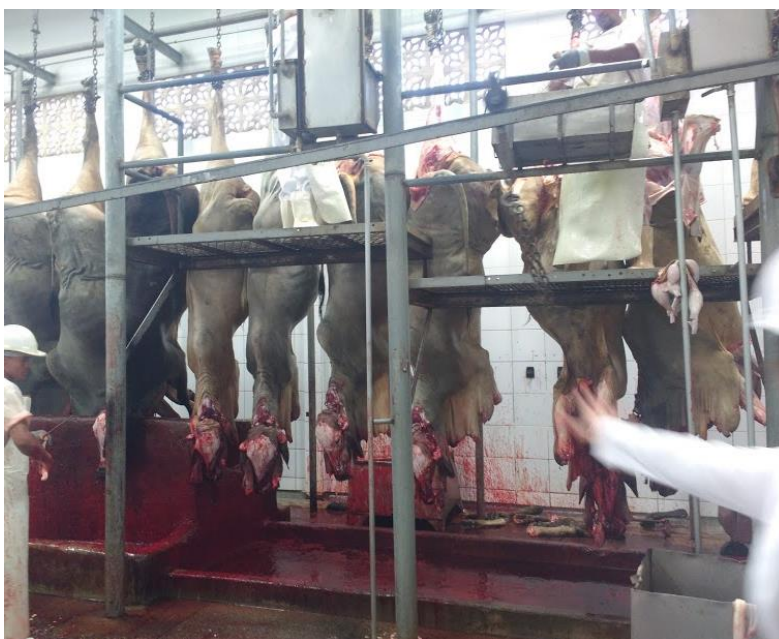
Figura 7- Sistema de escoamento de água e resíduos
