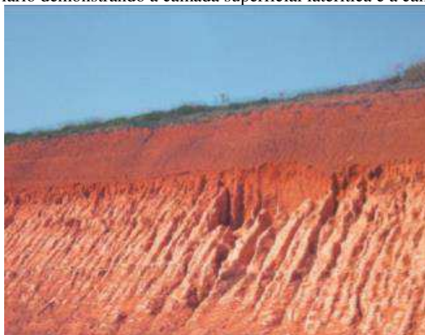
Figura 4 - Corte rodoviário demonstrando a camada superficial laterítica e a camada inferior saprolítica
