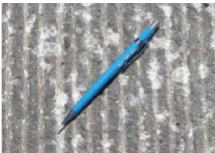
Figura 6: Superfície resultante da fresagem padrão
