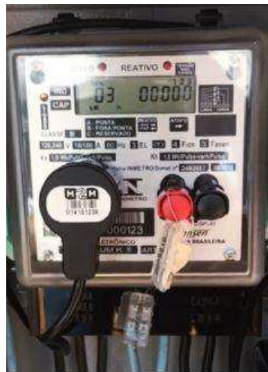
Figura 18 - Medidor bidirecional.
