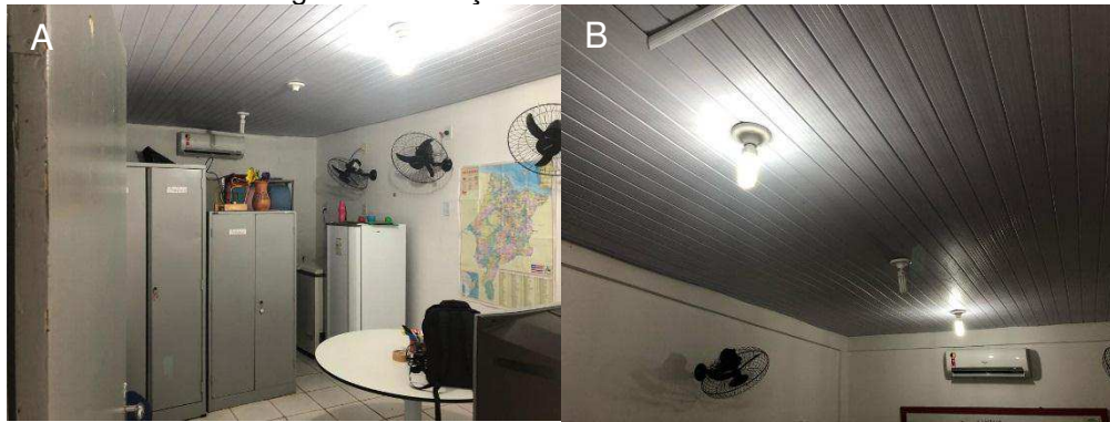
Figura 4 - Situações encontradas nas UBE's.
