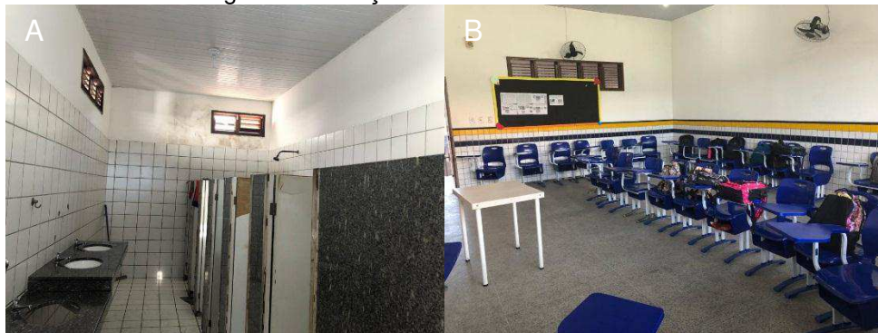
Figura 4 - Situações encontradas nas UBE's.
