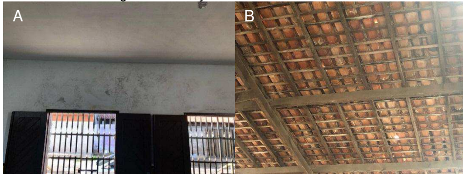
Figura 5 - Situações encontradas nas UBE's.
