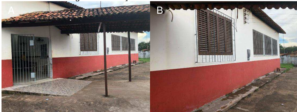
Figura 1 - Situações encontradas nas UBE's.
