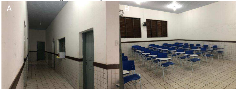
Figura 2 - Situações encontradas nas UBE's.
