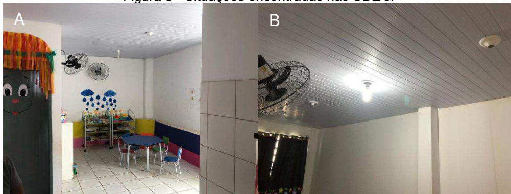
Figura 3 - Situações encontradas nas UBE's.
