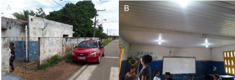
Figura 1 - Situações encontradas nas UBE's.
