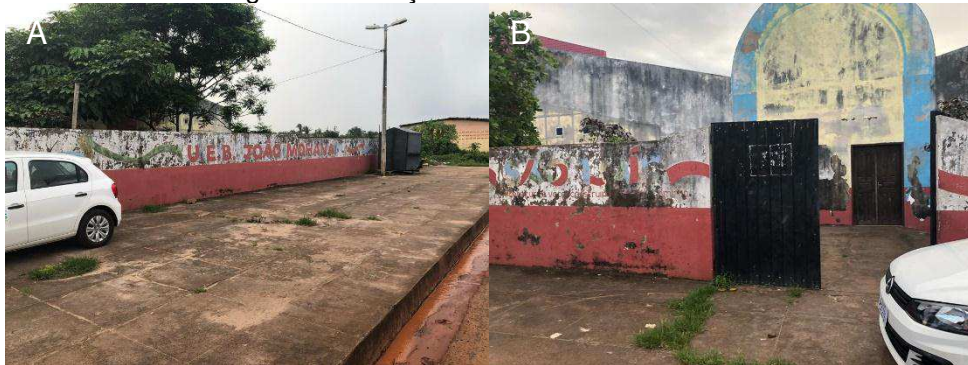
Figura 1 - Situações encontradas nas UBE's.
