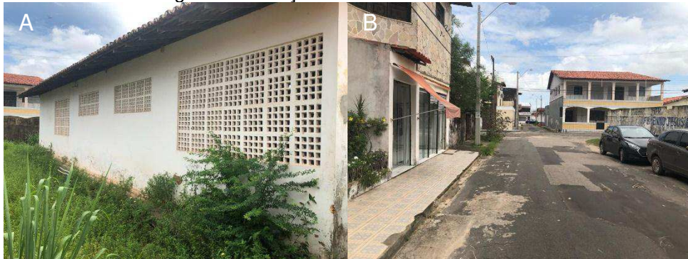
Figura 1 - Situações encontradas nas UBE's.
