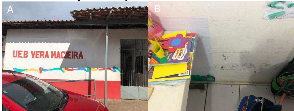
Figura 1 - Situações encontradas nas UBE's.
