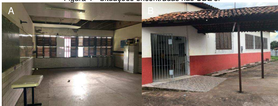
Figura 4 - Situações encontradas nas UBE's.
