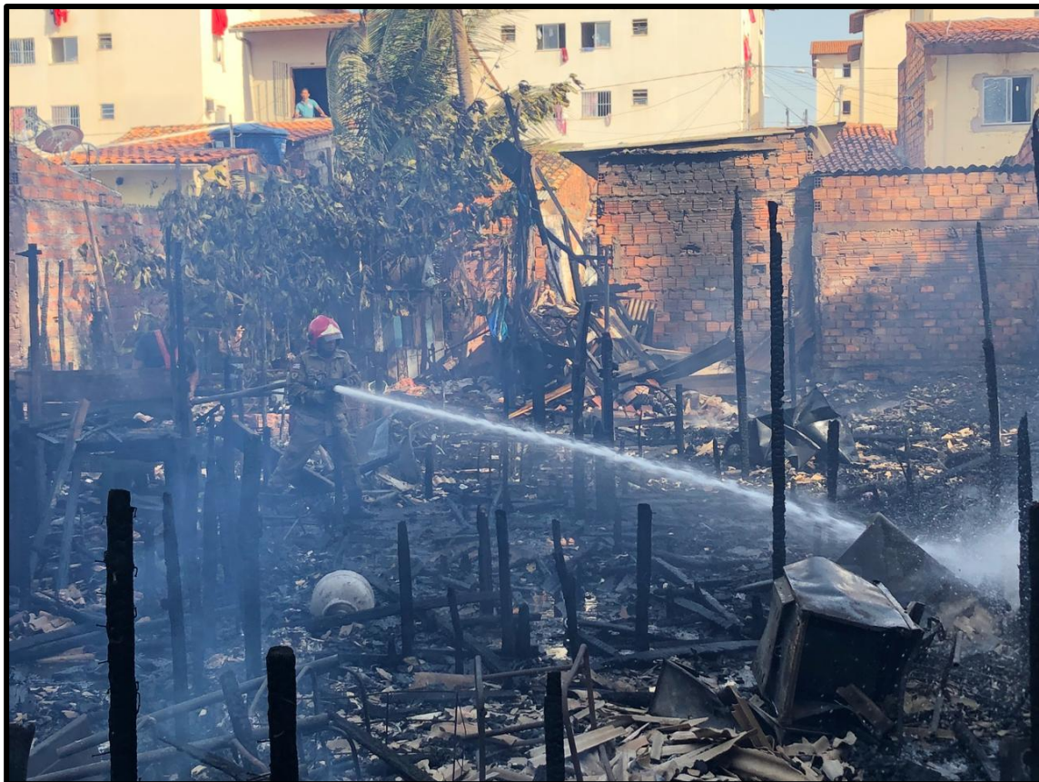
Figura 18 - Comunidade da Fé em Deus em São Luís – MA após incêndio
