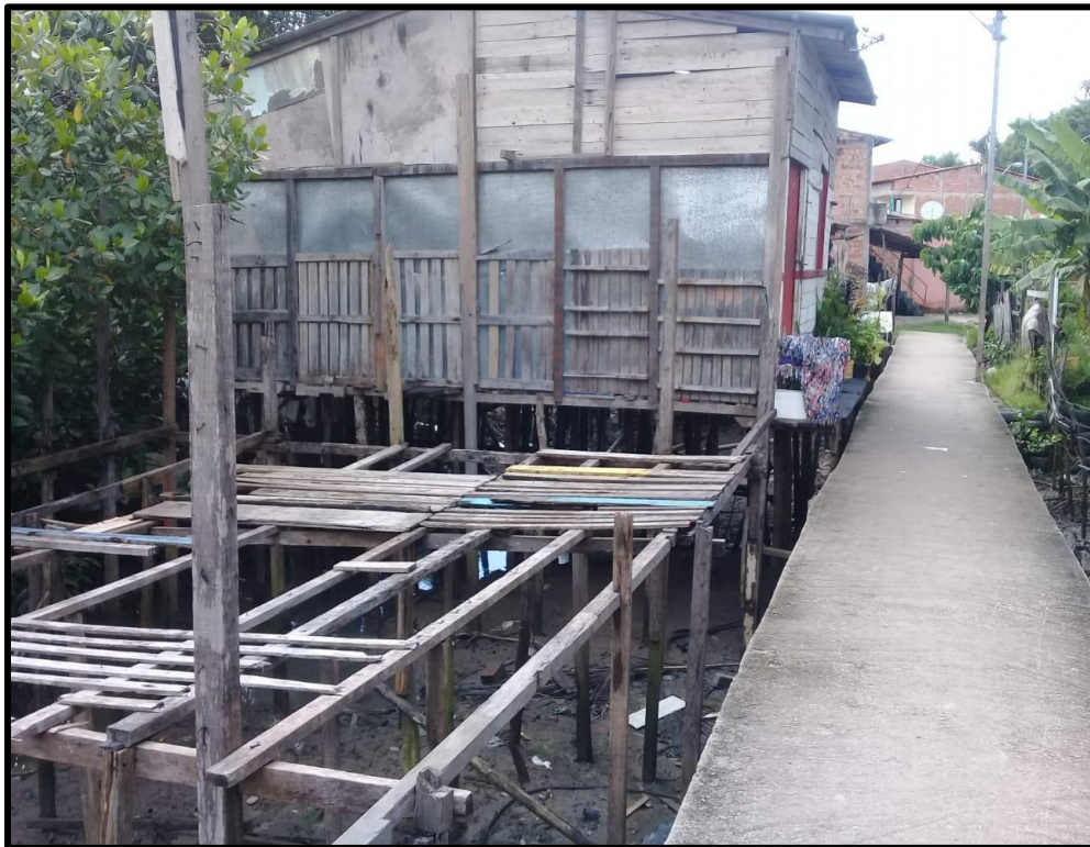
Figura 23 - Passarela na Vila Cerâmica
