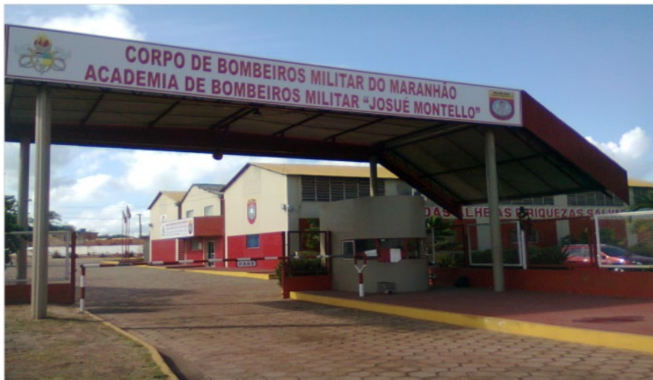
FIGURA 7 - Fachada da ABMJM
