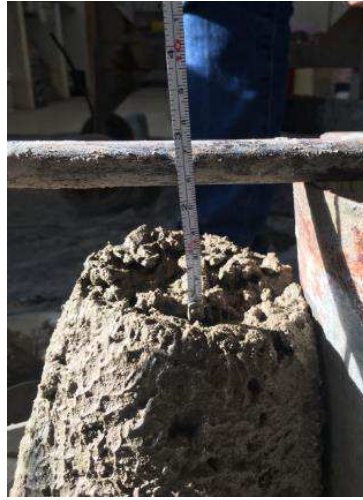
Figura 61 - Medição do Slump Test.
