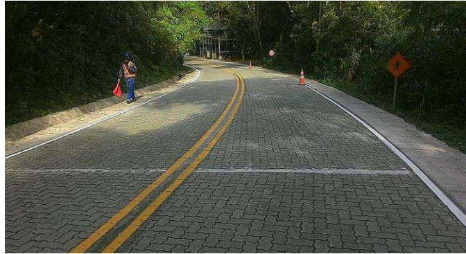
Figura 10 - Pavimento intertravado com bloco pré-moldado em avenida.
