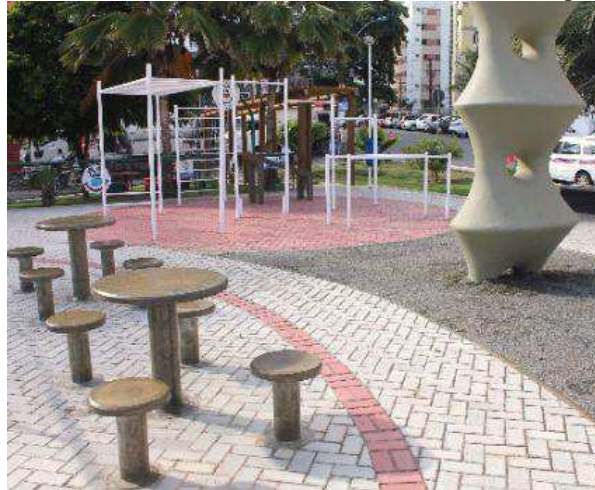
Figura 8 - Pavimento intertravado com bloco pré-moldado em praça pública.
