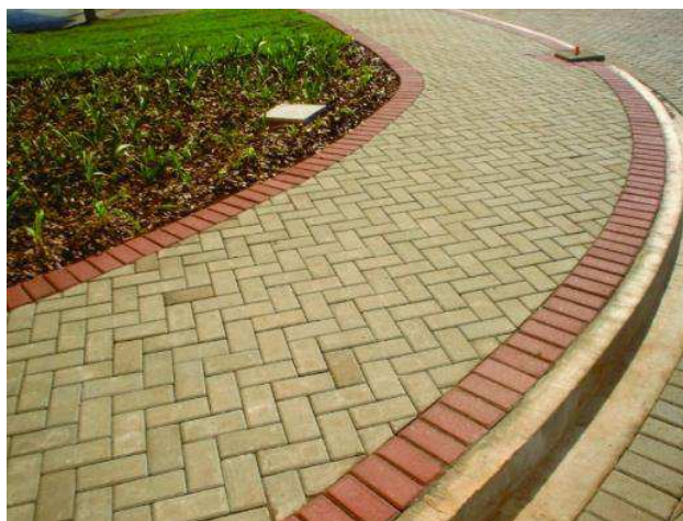
Figura 9 - Pavimento intertravado com bloco pré-moldado em calçada.
