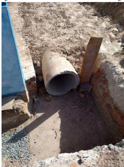
Figura 17 - Assentamento de tubos de drenagem
