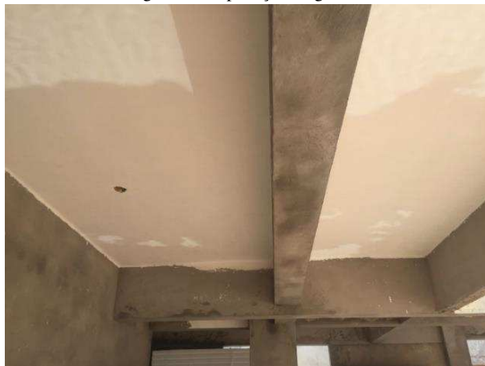
Figura 27 - Aplicação de gesso no teto
