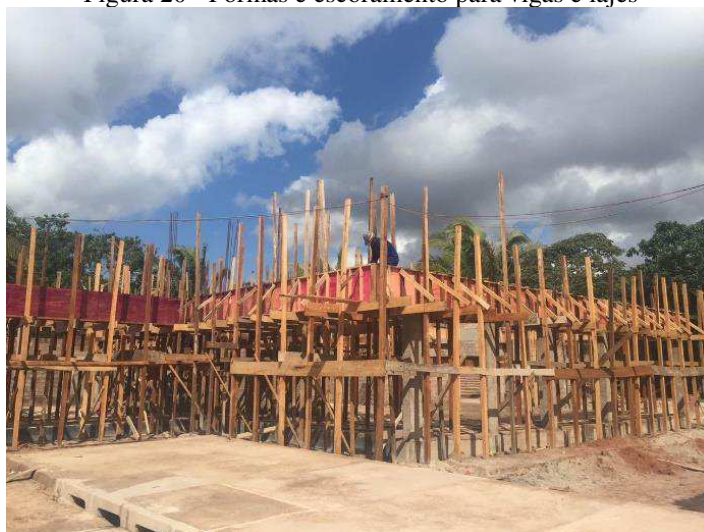
Figura 20 - Fôrmas e escoramento para vigas e lajes
