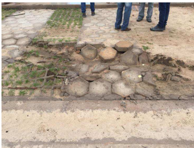
Figura 24 - Recalque no solo
