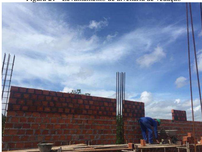
Figura 21 - Levantamento de alvenaria de vedação
