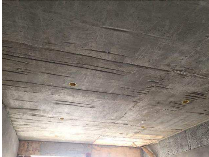
Figura 26 - Falhas de acabamento no teto
