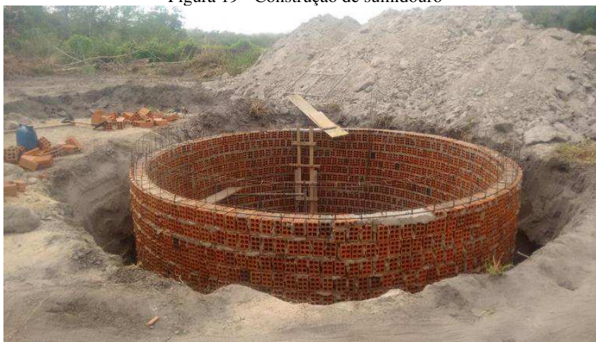
Figura 19 - Construção de sumidouro
