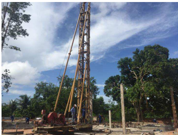
Figura 18 - Serviço de cravação de estaca
